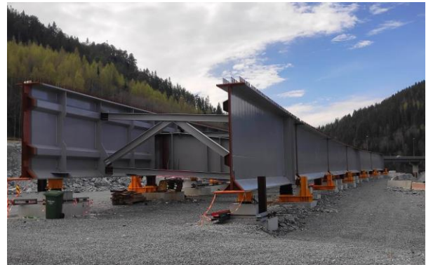
Figura 9. Tablero del K62 en el parque de prearmado.
