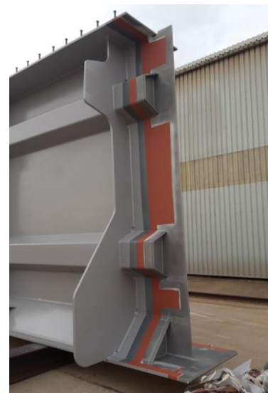
Figura 10. Diferentes capas del System 1 aplicado en taller.
