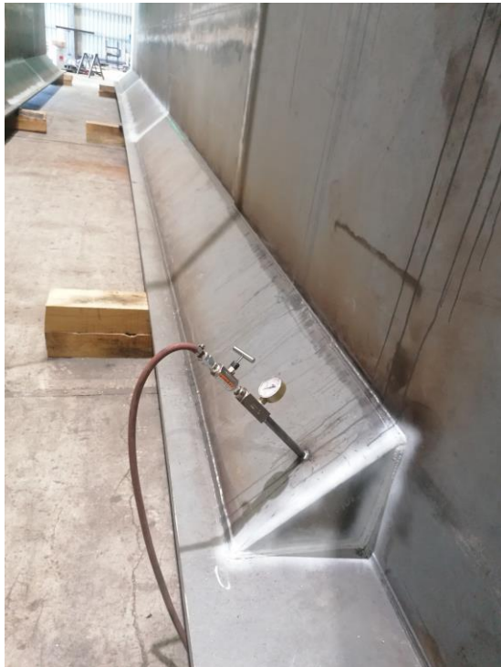
Figura 15. Prueba de estanqueidad en las células triangulares del ala inferior.
