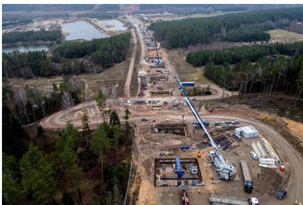
Figura 1. Obras de construcción del puente sobre el río Neris.
