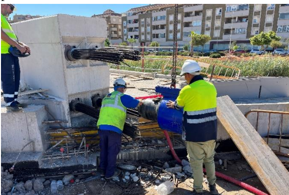
Figura 16. Momento del enhebrado del gato multicordón
