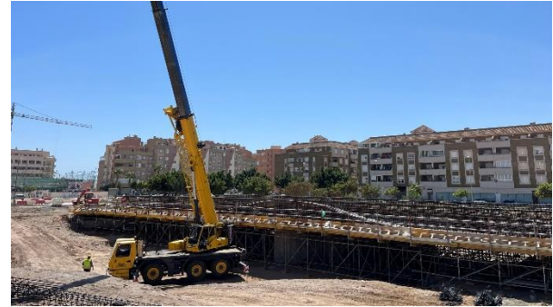
Figura 13. Imagen general del puente durante el montaje de la ferralla, con el trazado de las vainas sobre pila
