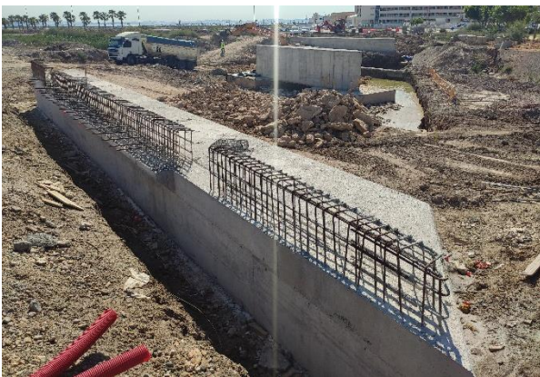
Figura 11. Subestructura preparada para recibir el tablero
