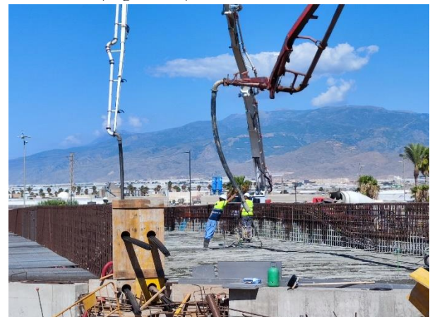
Figura 14. Hormigonado de la parte inferior de la losa del puente
