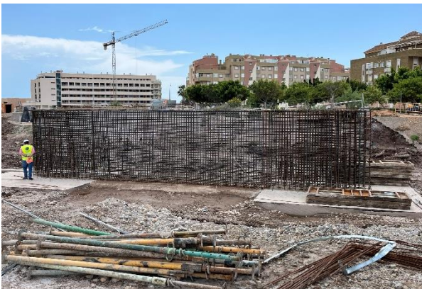
Figura 12. Armado de la pila tabique, sobre los encepados pilotados
