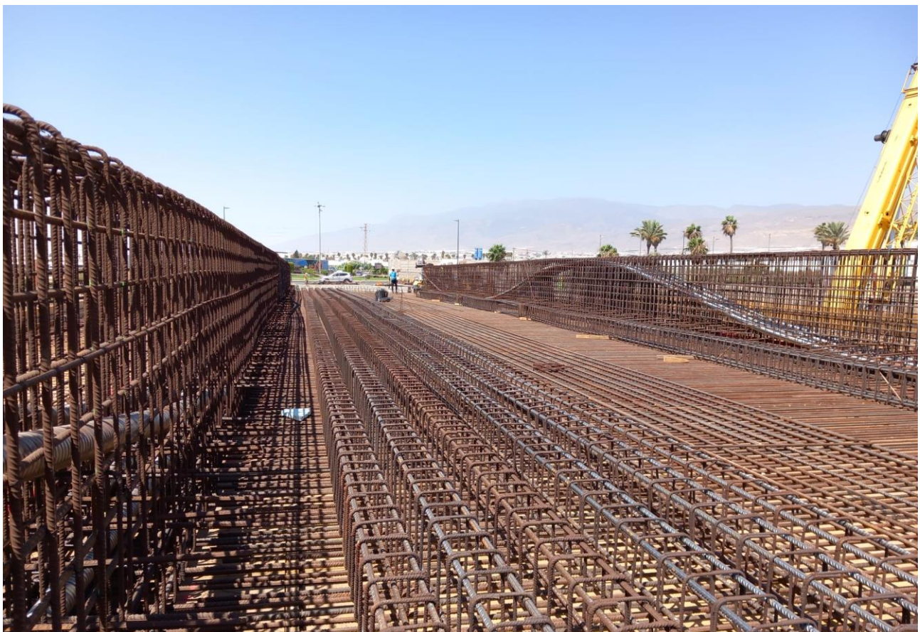
Figura 19. Ferrallado del tablero, con las vainas en fase de ajuste de trazado
