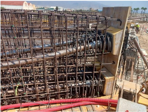
Figura 15. Zonas de anclaje de los tendones de postesado, previo al hormigonado
