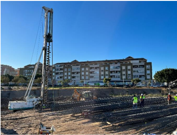
Figura 10. Ejecución de pilotes con barrena continua, de hasta 20 m de profundidad
