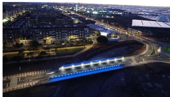
Figura 2. Vista nocturna de la estructura
