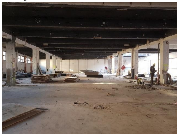
Figura 1. Vista de la configuración de la estructura
