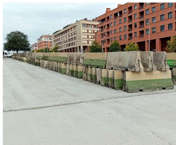
Figura 19. Precarga del tablero previa al hormigonado de la losa en las zonas de empotramiento
