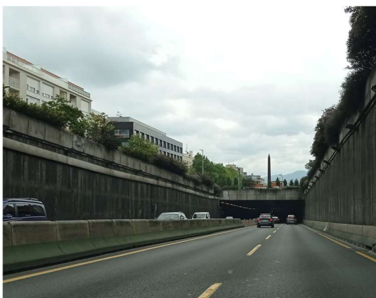
Figura 2. Trinchera abierta a cubrir
