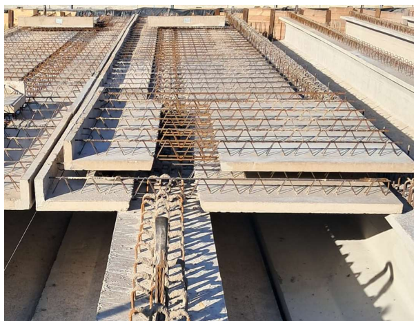
Figura 16. Ejecución de una junta de tablero
