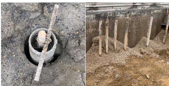
Figura 22. Micropilotes en fase de ejecución
