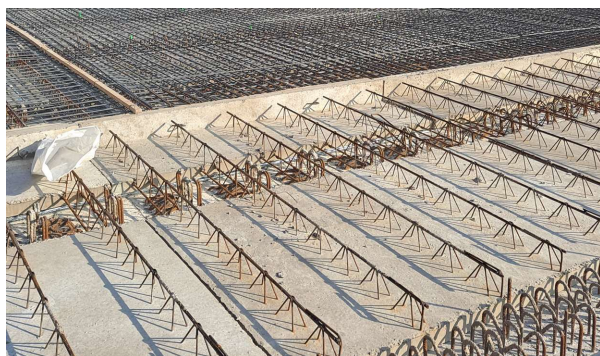
Figura 17. Prelosas de celosía en junta de tablero
