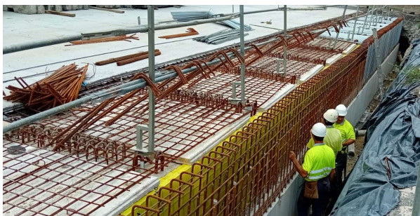
Figura 20. Vista del espaldín previa al hormigonado
