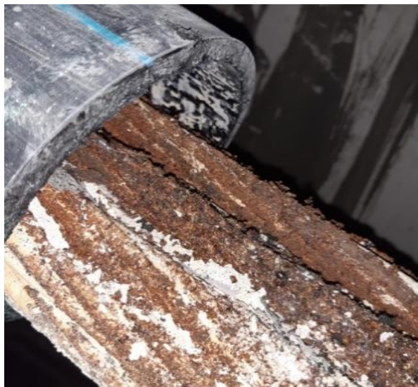
Figura 8. Presencia de oxidación en los cordones
