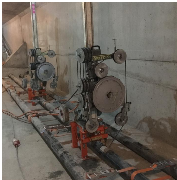
Figura 10. Máquinas de corte con hilo de diamante en posición
