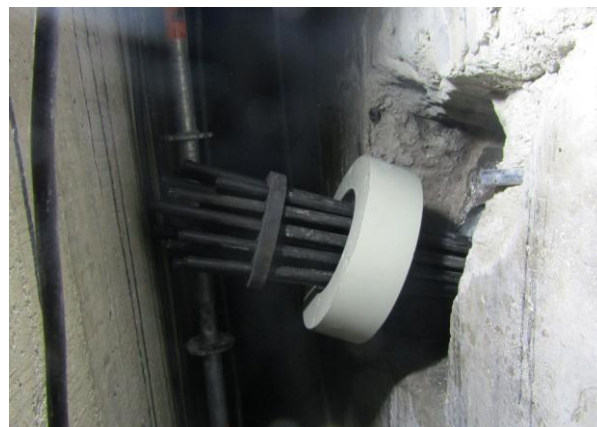
Figura 12. Detalle de la instalación del sistema de anclaje de unos de los nuevos tendones del E-2
