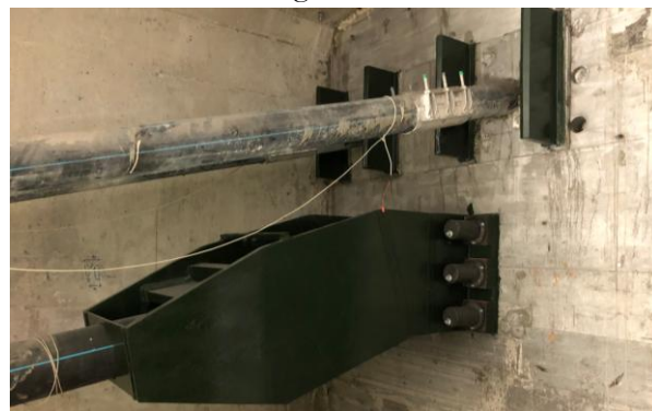
Figura 12. Marco de anclaje en el tendón 4 sustituido.
