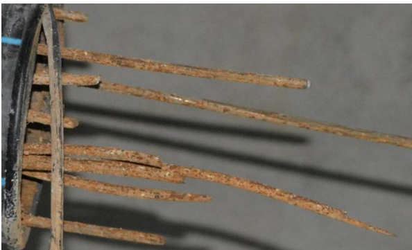
Figura 6. Vista lateral del tendón roto, con algunas roturas en ‘pico de flauta’ en los alambres.
