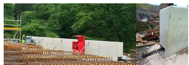
Figura 4. Viga de prueba de inyección a escala real.
