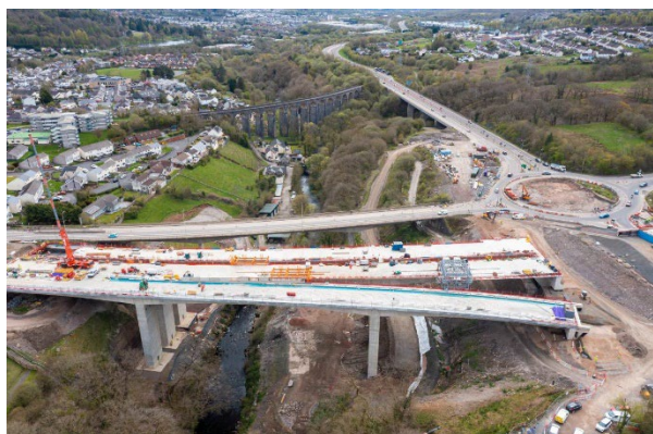
Figura 1. Vista general de los puentes existente y nuevo en construcción en abril de 2024.
