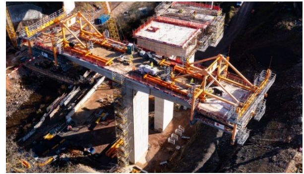
Figura 9. Carros de hormigonado.
