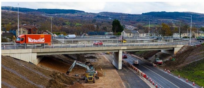
Figura 3. Puente de Trewaun Oeste
