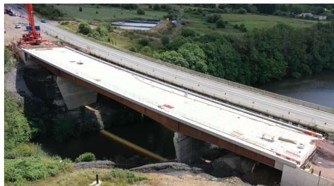
Figura 12. Puente de Nant Hir.
