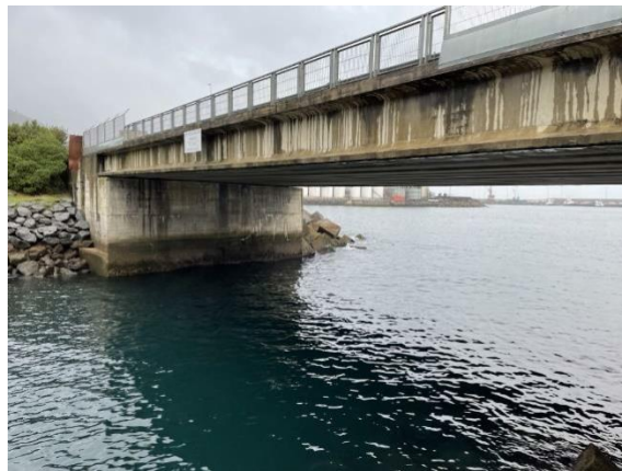
Figura 1. Vista de uno de los puentes del Puerto de Zierbena.
