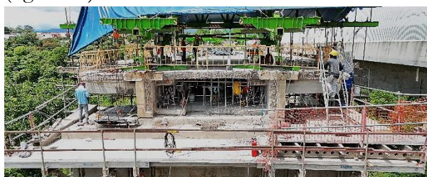
Figura 12. Vista de trabajos de demolición y ampliación de diafragma de pila 1
