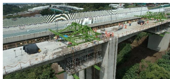
Figura 20. Vista aérea de los carros de reparación
