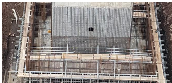
Figura 17. Vista de pila 3 durante el ferrallado de refuerzos de cimentaciones y fustes
