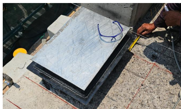
Figura 7. Aparato de apoyo de neopreno deslizante
