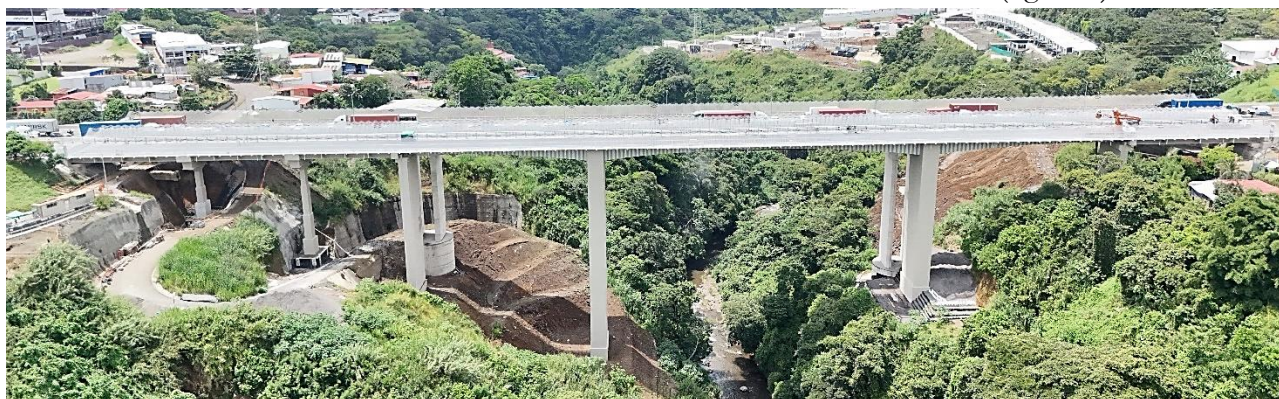
Figura 1. Alzado del puente. A la derecha el estribo 1
