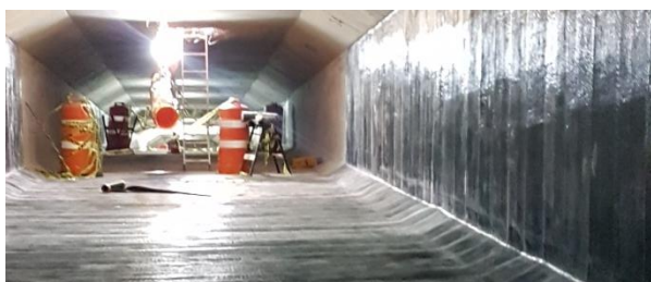
Figura 14. Refuerzo con fibras del interior del cajón
