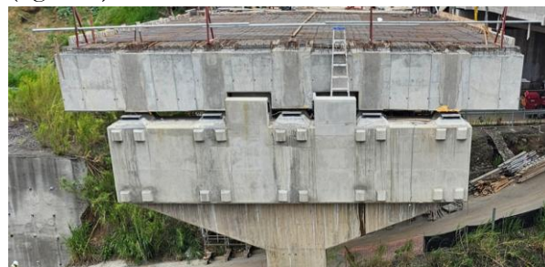
Figura 8. Pila 5 vista transversal con topes sísmicos y diafragma
