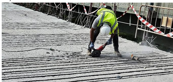
Figura 15. Ejecución de rozas sobre tablero cajón
