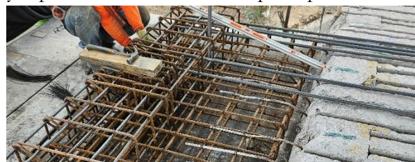
Figura 16. Ejecución de ampliación del tablero cajón
