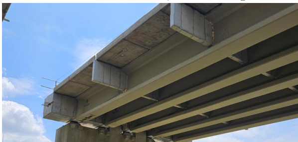
Figura 9. Vista inferior de uno de los vanos de vigas con diafragmas intermedios y en apoyos
