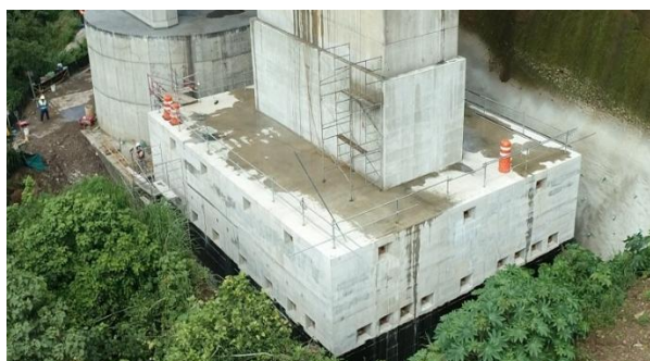
Figura 18. Vista de pila 2 con refuerzos en cimentación y fustes ejecutados
