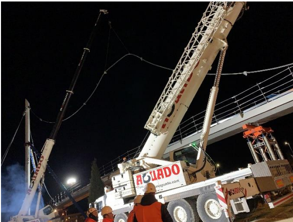
Figura 19. Instalación del primer cable principal.
