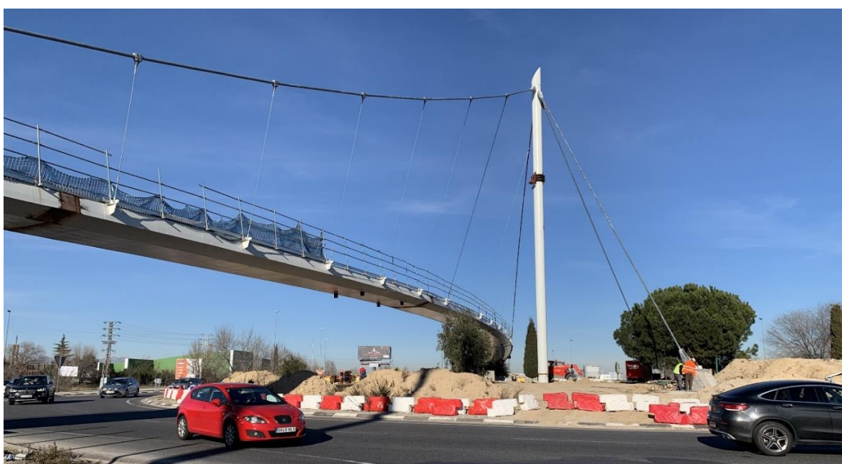
Figura 23. Pasarela durante la construcción, tras el desapeo de las torres provisionales.
