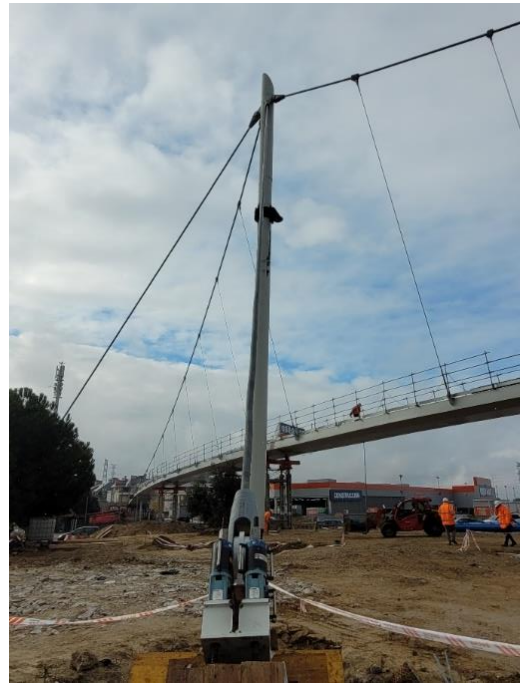
Figura 20. Tesado de cables de retenida.
