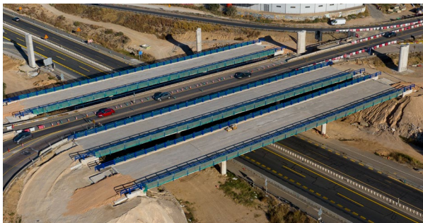
Figura 1. Vista aérea de las estructuras E-10, E-11 y E-12, y pilas en espera de la E-13
