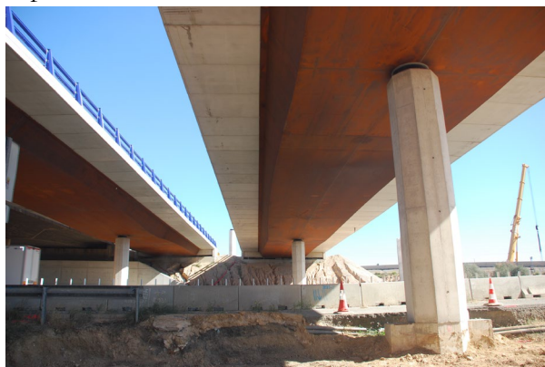
Figura 19. Pila de sección octogonal
