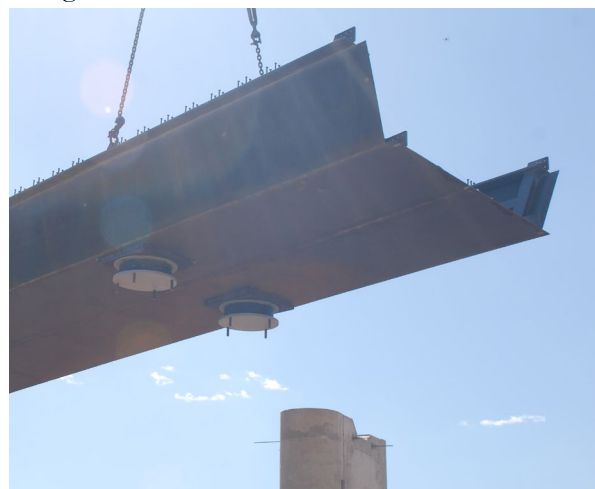
Figura 17. Apoyos anclados atornillados al cajón metálico de la E-13
