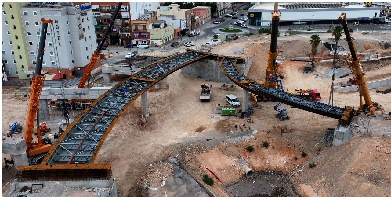
Figura 10. Estructuras E-1 y E-2 durante la ejecución
