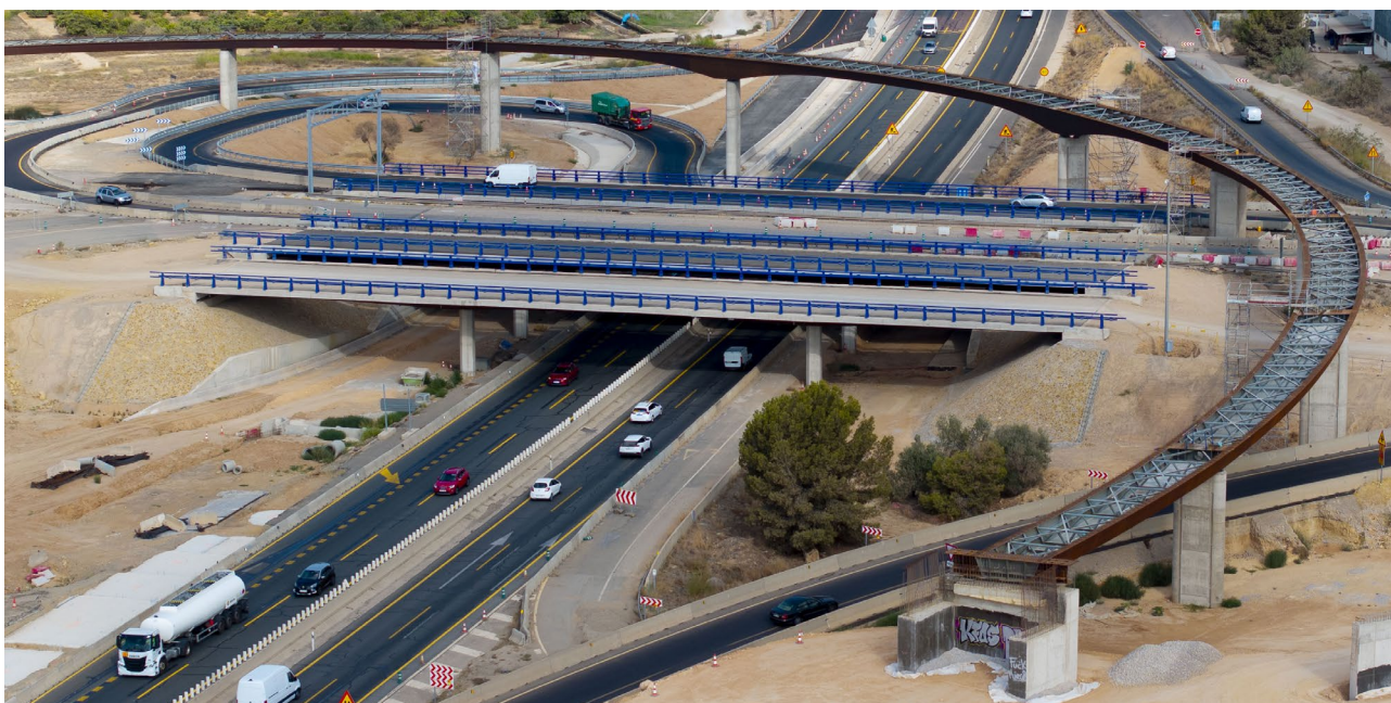
Figura 2. Vista aérea de las estructuras E-10, E-11, E-12 y E-13 (sin losa superior)
