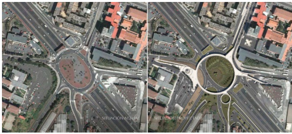
Figura 3. Estado actual de la glorieta del Padre Anchieta y con la nueva pasarela.
