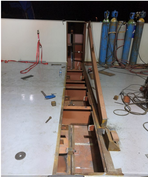
Figura 19. Detalle de unión entre módulos
