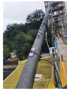
Figura 14. Acelerómetros en tirantes antiguos
