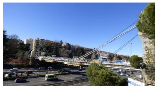
Figura 17. Vista general de la obra
