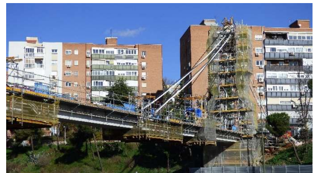
Figura 16. Vista lado La Elipa
