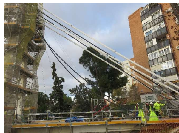
Figura 15. Descenso de tirantes de retenida antiguos
