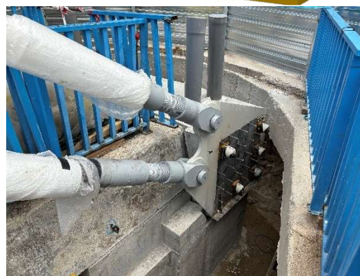
Figura 7. Esquema de conexión en estribo
