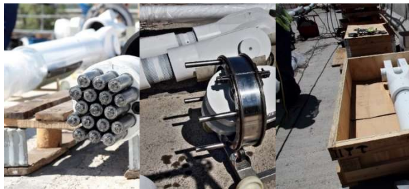
Cordón y manguito de extrusión Anclaje fijo Anclaje regulable
