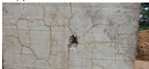
Figura 5. Reacción álcali
