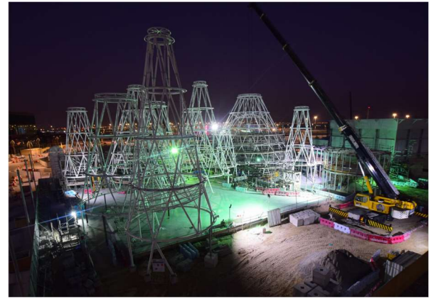
Figura 28. Fotografía montaje cúpula principal
