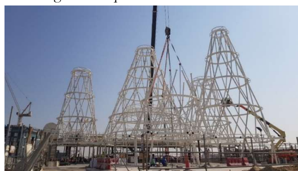
Figura 25. Fotografía montaje conos sobre diafragma
