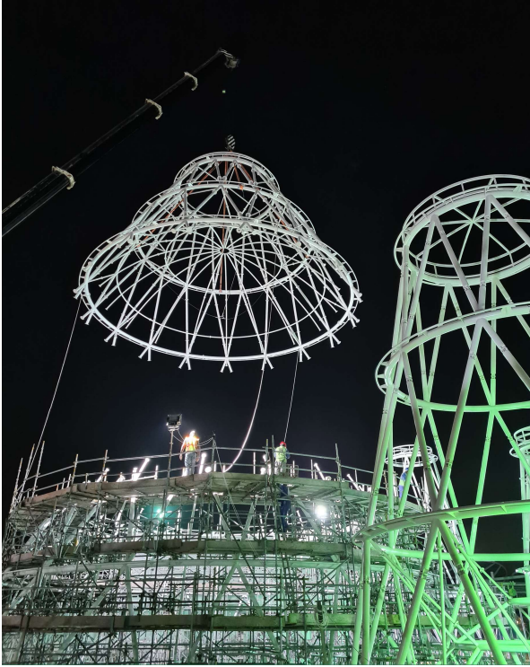
Figura 26. Fotografía montaje cúpula principal
