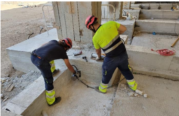
Figura 18. Inyección de anclajes pretensados
