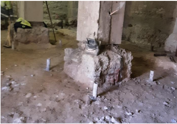
Figura 15. Ejecución de micropilotes para recalce
