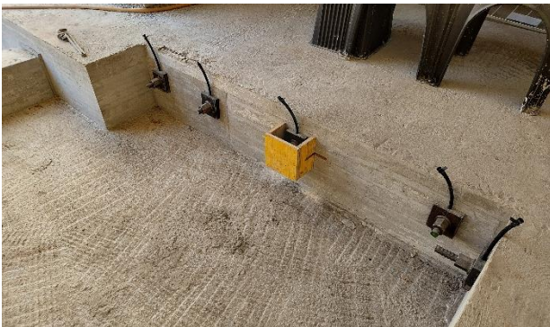
Figura 17. Recalce hormigonado. Se aprecian los manguitos para la inyección de la armadura activa
