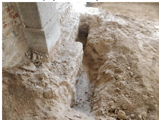
Figura 14. Zanjas de cimentación alrededor de muros y arcos existentes.
