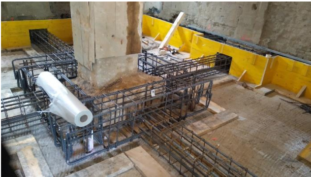
Figura 16. Disposición de ferralla alrededor de una cimentación existente
