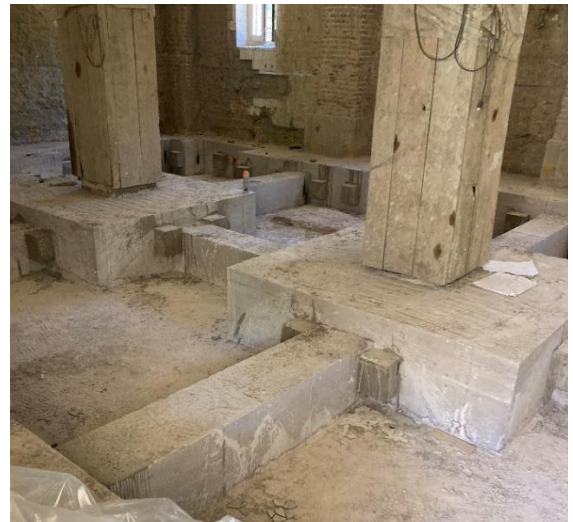
Figura 19. Vista del recalce finalizado
