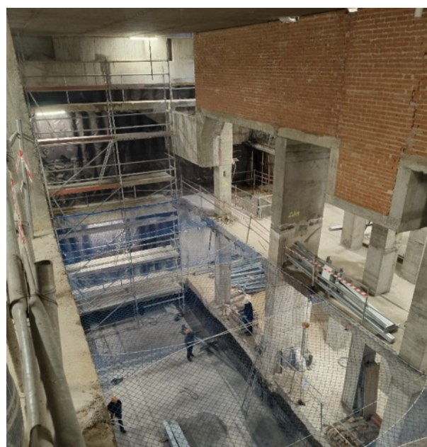
Figura 13. Fotografía de obra: ejecución de bajo rasante completa a excepción del hormigonado de las vigas de salto de nivel entre losas de cimentación mediante gunitado (ver esquema Figura 4). 16.11.22.
