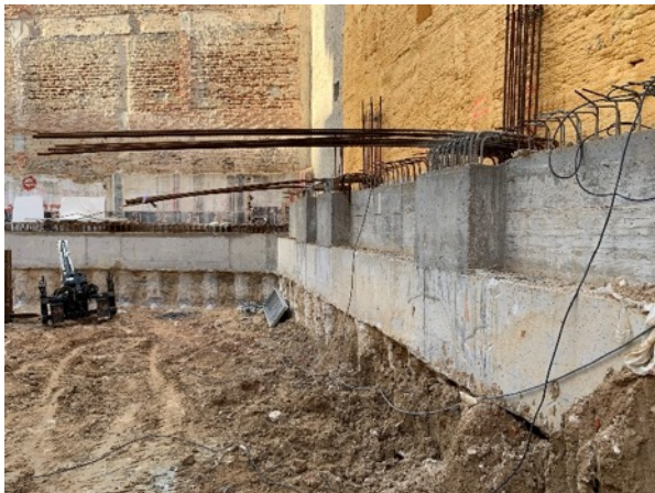
Figura 6. Fotografía de obra: vista de la pantalla de pilotes discontinua de la medianería y zona trasera.
