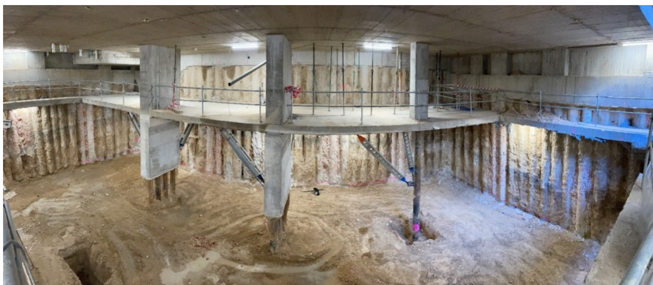
Figura 10. Fotografía de obra: vista de bajo rasante. Excavación hasta nivel 3 (sótano -2), arriostramientos provisionales de micropilotes de 35 cm y hormigonado del tramo superior de los pilares de H.A. 19.01.22.
