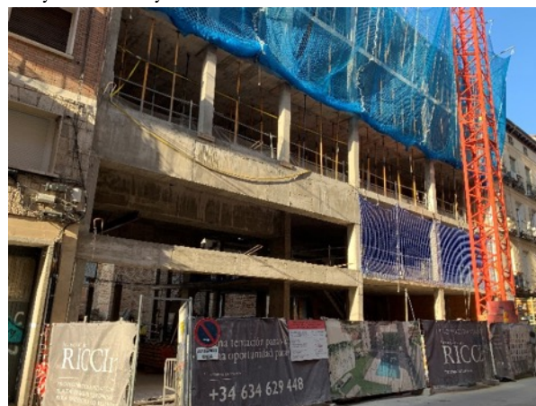
Figura 3. Fotografía de obra: vista de la fachada principal con los tres primeros forjados y la zona de entrada al aparcamiento con su doble altura y las vigas de canto para el apeo de los pilares de los niveles superiores. 18.08.21.
