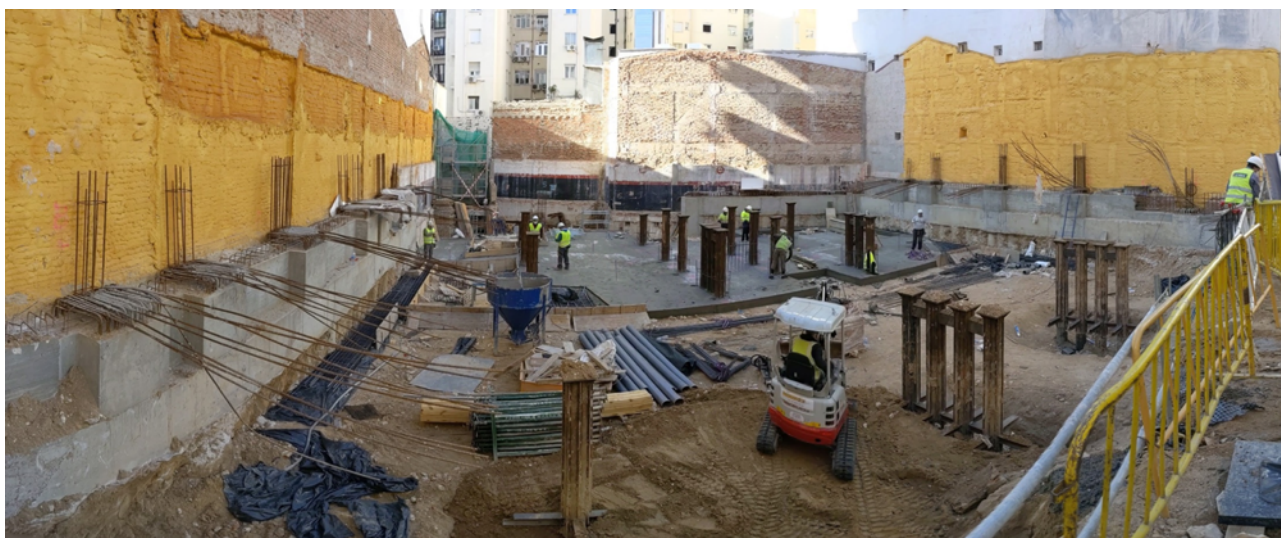
Figura 8. Fotografía de obra: vista de la pantalla de pilotes discontinua, de la viga de coronación, de las ménsulas de transferencia de cargas en la medianería del edificio con el armado de refuerzo a hormigonar dentro de la losa maciza del forjado de planta baja. En la zona central de la fotografía vista de los micropilotes de 35 cm de diámetro ubicados donde se ejecutarán los pilares definitivos del edificio en H.A. Se aprecia también el hormigonado de la mitad trasera de la losa de sótano -1 contra el terreno. 24.03.21.
