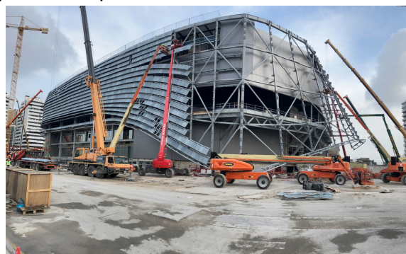
Figura 15. Construcción fachada noroeste © E.Goberna
