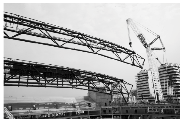
Figura 6. Elevación de las cerchas © R.Piñol
