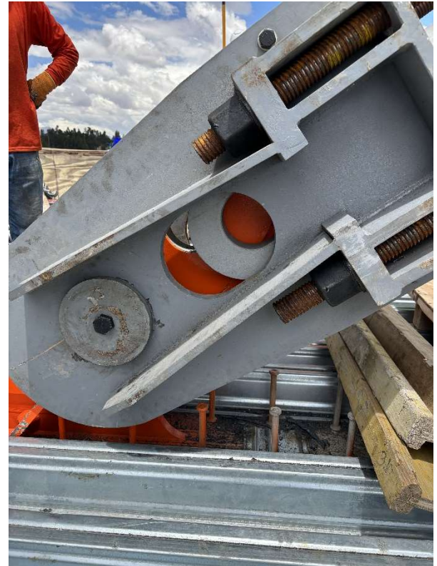
Figura 19. Conexión de horquilla inferior para unidades de 19 y 27 cordones.
