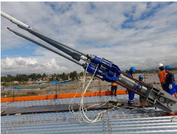
Figura 18. Enfilado de barras para unidades de 19 y 27 cordones.
