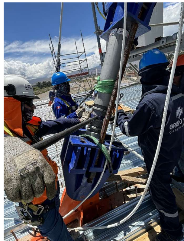
Figura 16. Sistema de tesado para unidad de 12 cordones.
