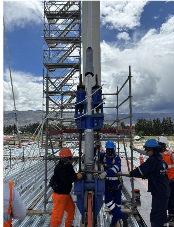
Figura 15. Sistema de tesado para unidad de 12 cordones.
