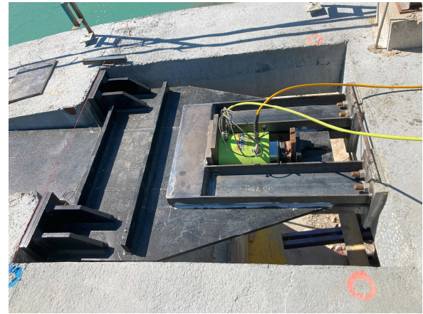
Imagen 8. Banda tesada mediante gato hidráulico (dcha.) © sbp
