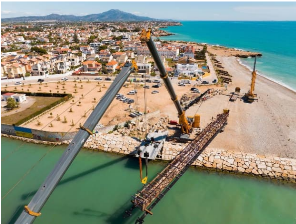
Imagen 7. Vista aérea durante el izado de las bandas tesa. © GeoDroneAir
