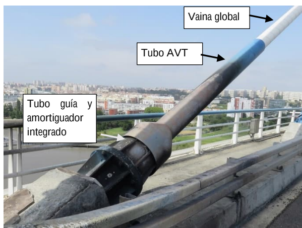
Figura 6. Léxico de componentes del tirante.
