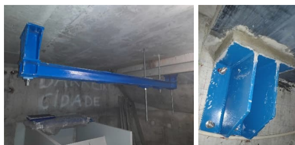
Figura 9. Refuerzo en el interior del pilono para el apoyo y tiro de la viga de izado.
