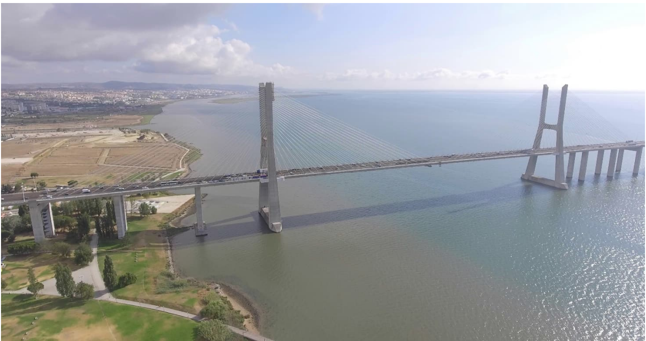
Figura 1. Vista general del tramo atirantado.
