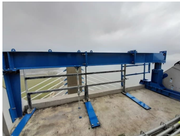
Figura 8. Viga de izado en curso de montaje sobre tapa de cierre de pilono.
