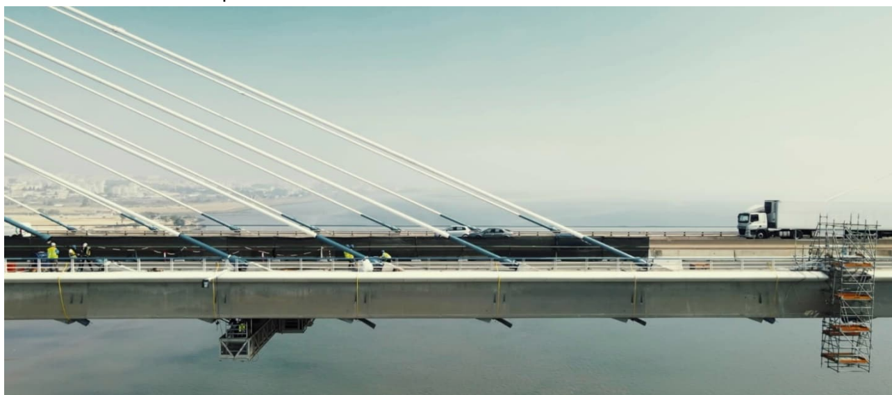
Figura 12. Vista general – plataforma de servicio móvil y acceso.
