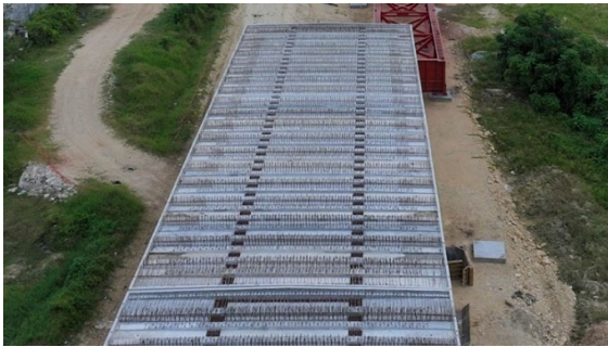
Figura 23. Vista general de las losas de hormigón prefabricado.
