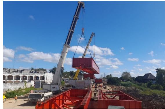
Figura 21. Izado de las vigas metálicas.
