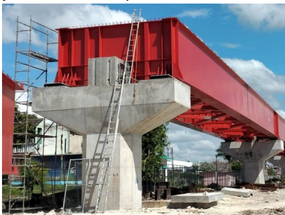
Figura 7. Vista general de la columna.
