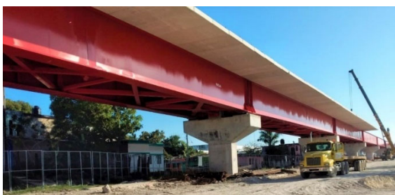
Figura 4. Vista general de los vanos mixtos simplemente apoyados.
