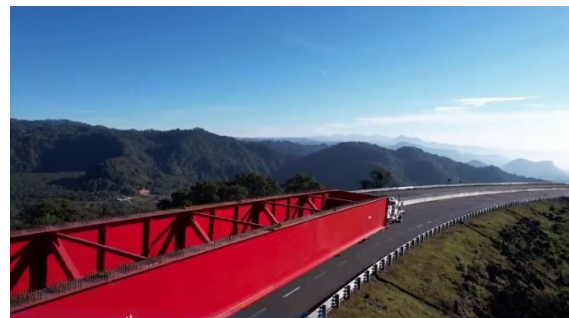
Figura 17. Transporte de vanos de 40 m terminados.
