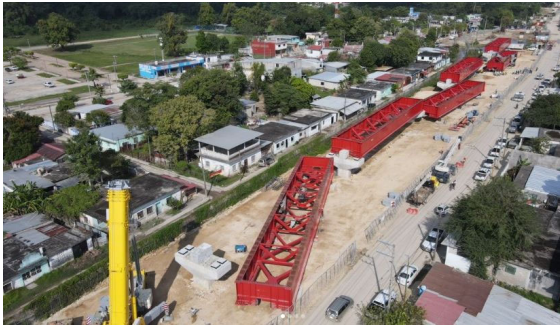
Figura 19. Vigas metálicas almacenadas en obra esperando ser izadas.
