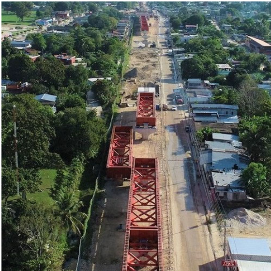
Figura 15. Montaje de múltiples vanos sin un orden específico.
