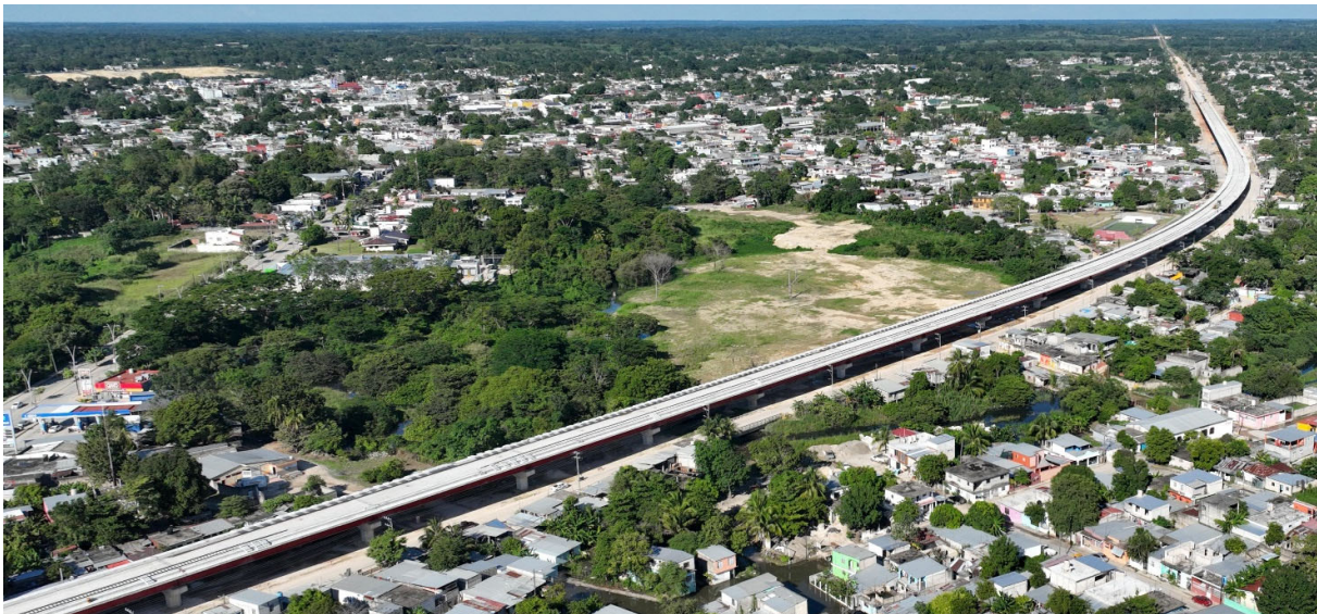
Figura 14. Vista general de extremo final del Viaducto de Tenosique terminado.
