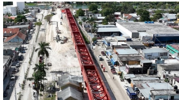
Figura 3. Sucesión de múltiples vanos simplemente apoyados.
