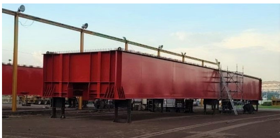
Figura 27. Ensamblaje de semivanos en el taller para formar un vano de 40 m.
