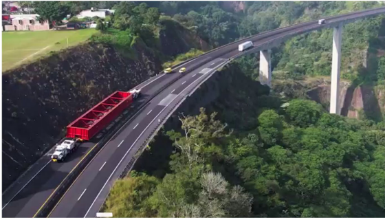
Figura 18. Transporte por carretera de vanos de 40 m terminados.
