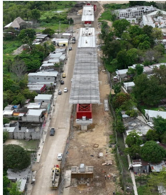
Figura 16. Ejecución simultánea de varios elementos estructurales.
