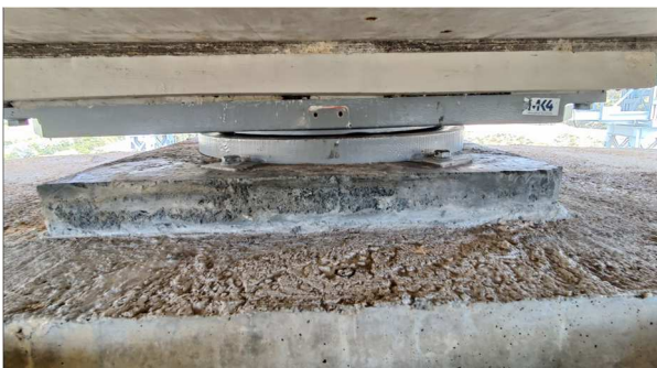
Figura 5. Apoyo POT en pila.
