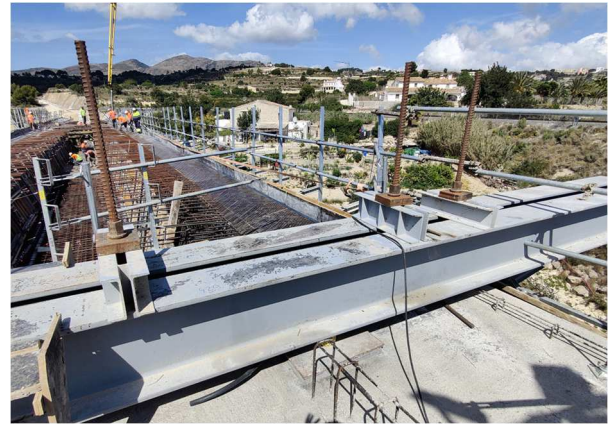
Figura 17. Vigas metálicas sobre el tablero que recogen el cuelgue de la cimbra.
