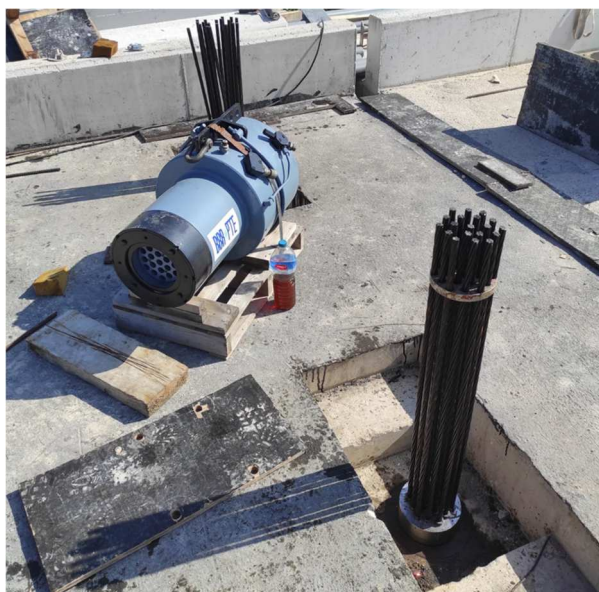
Figura 21. Detalle anclajes verticales punto fijo.
