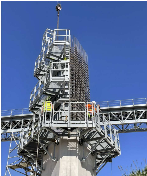
Figura 4. Encofrado trepante para fuste de pila.
