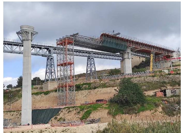
Figura 10. Construcción del vano tipo con cimbra porticada.
