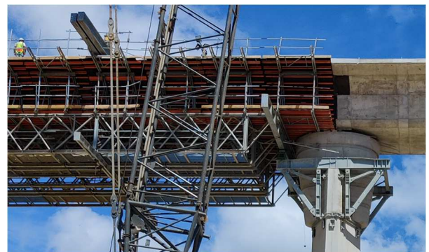
Figura 18. Cimbra tras el cuelgue del tablero ya hormigonado.
