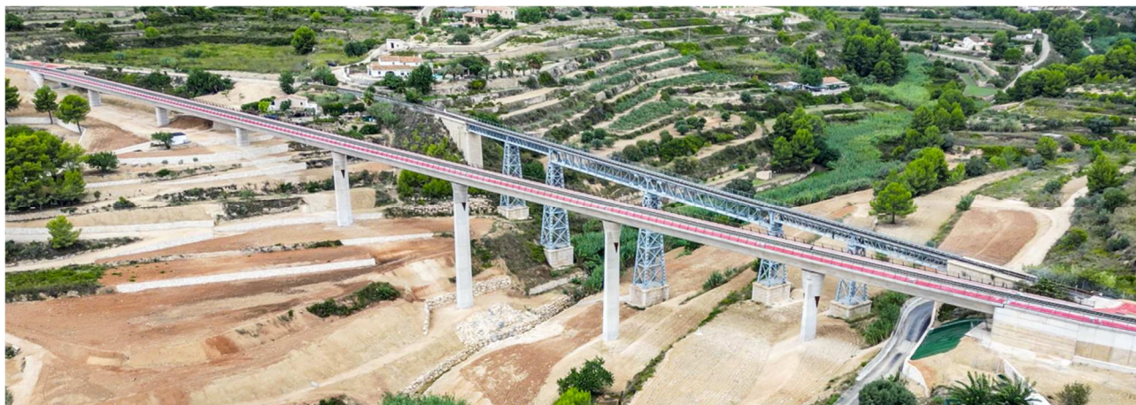
Figura 1. Vista general del viaducto construido delante del antiguo viaducto de Santa Ana.
