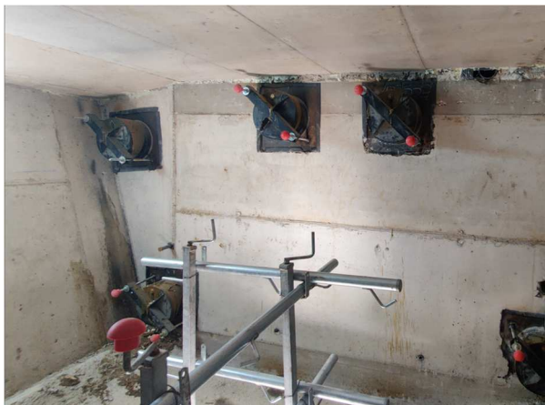
Figura 20. Detalle anclajes punto fijo.
