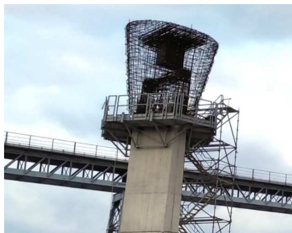
Figura 3. Armadura del capitel de pila. Incluye foso para inspección en el interior.
