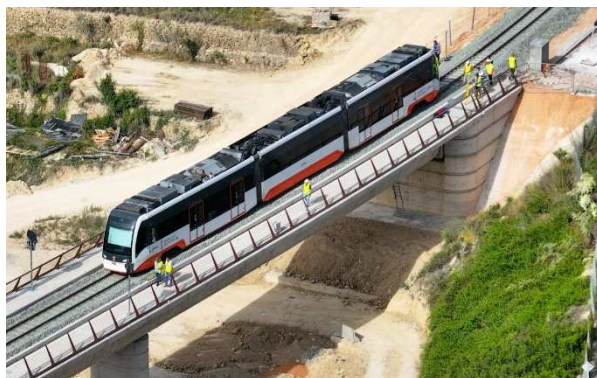
Figura 23. Prueba de carga.
