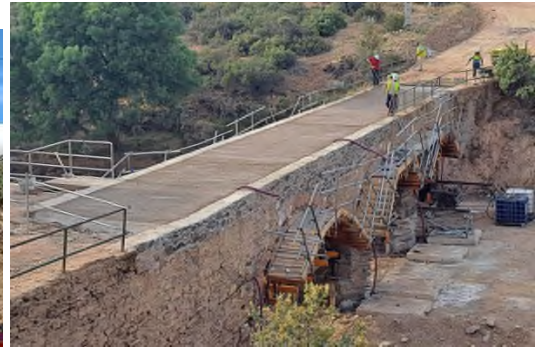
Figura 8. Ensayado de las bóvedas (Hormigonado de tablero).
