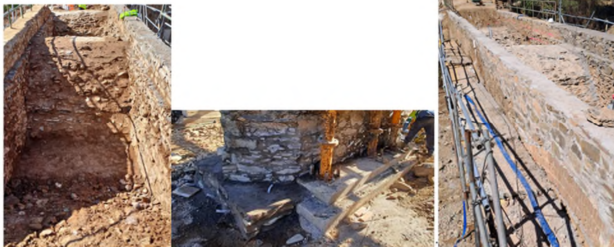
Figura 7. Ejecución de vaciado de los senos de las bóvedas, inyección de sellado de la sillería de las pilas y reconstrucción de tímpanos.
