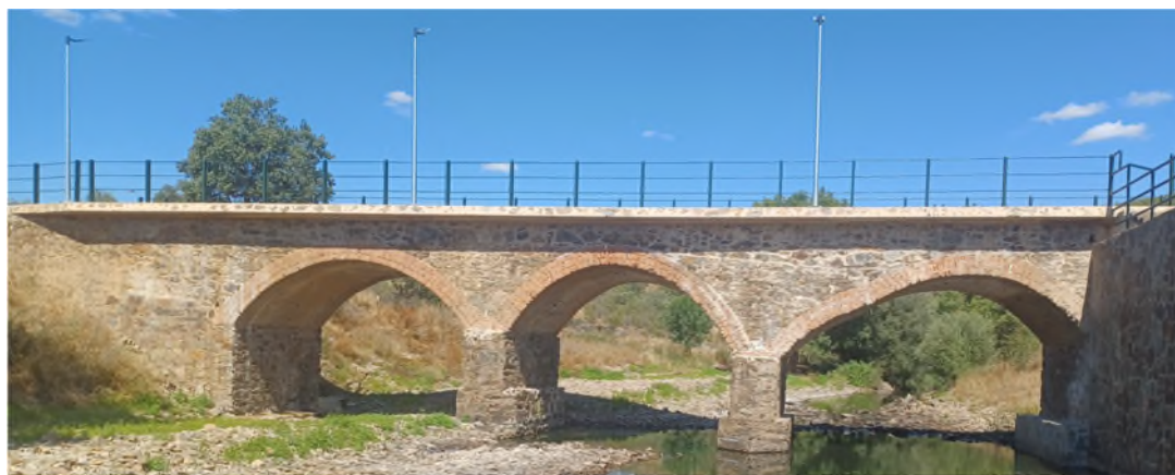
Figura 11. Puente en servicio después de rehabilitación en junio 2023.
