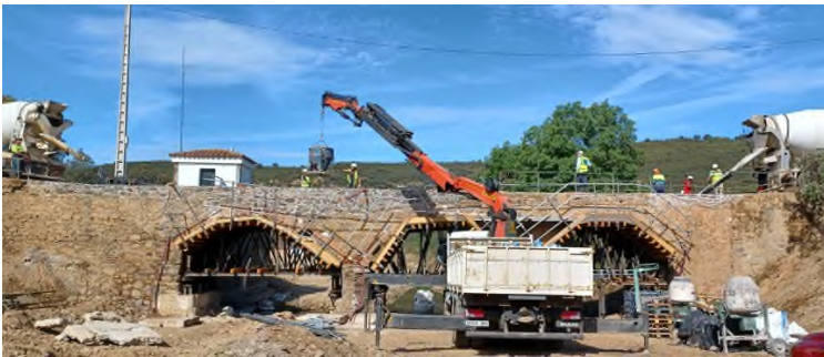
Figura 8. Ensayado de las bóvedas (Hormigonado de tablero).
