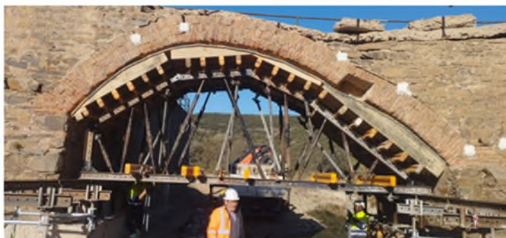
Figura 6. Disposición de cimbra mediante ripado para apeo de las bóvedas.
