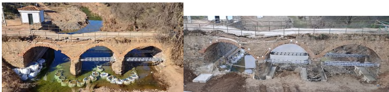
Figura 5. Actuaciones de emergencia. Protección cimentaciones, hormigonado de huecos en cimentación e instalación de arriostramientos en arranque de bóvedas 2 y 3.
