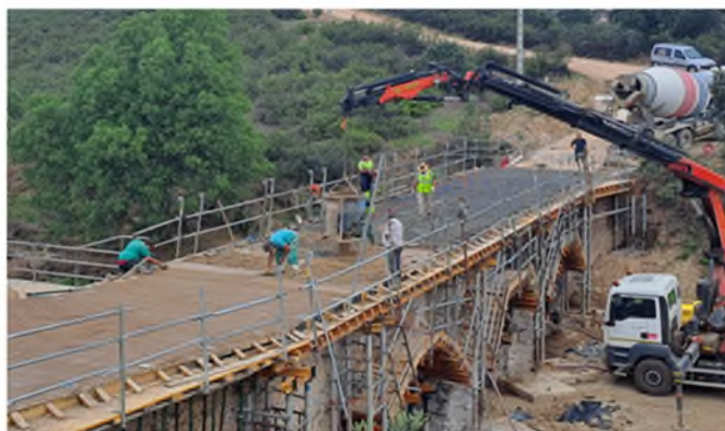
Figura 10. Ejecución de losa de hormigón armado para plataforma.
