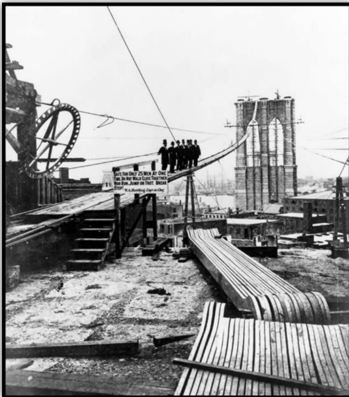
Figura 8. Puente de Brooklyn en construcción
