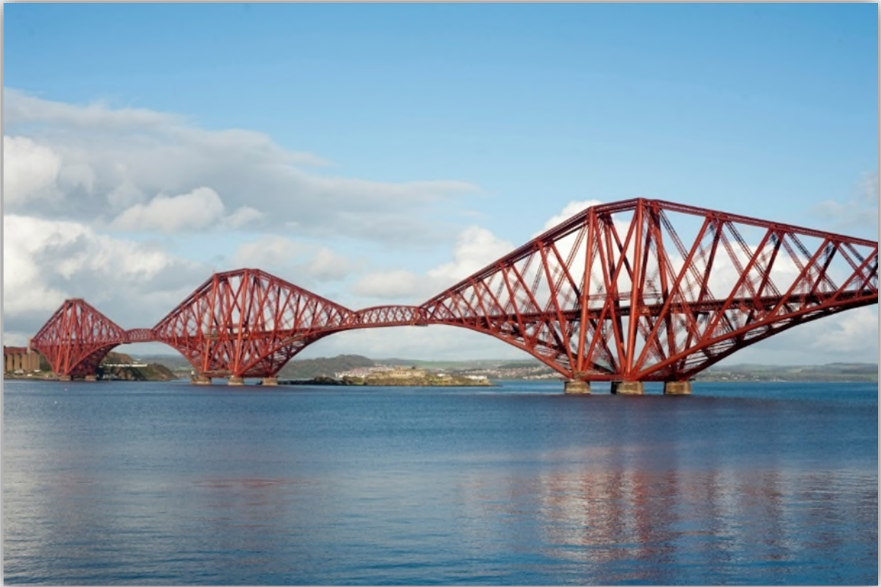
Figura 6. Vista general del Firth of Forth
