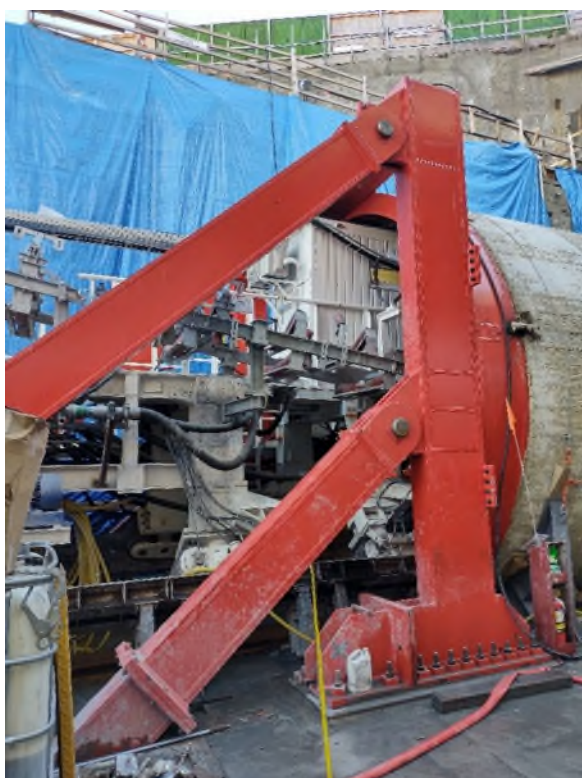
Figura 20. Vista lateral de la estructura de reacción.
