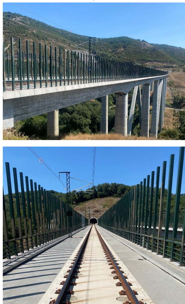
Figura 1. Viaducto de Teixeira: vista general de la estructura (arriba) y de la vía en placa (abajo). Fotografías del autor C. Zanuy (agosto 2024).
