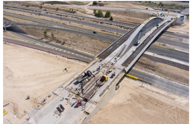
Figura 21. Losa de hormigón en sección central de 12 m
