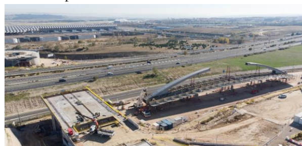
Figura 19. Estructura de acero montada en obra
