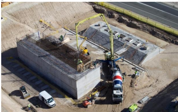
Figura 16. Descripción general de las cimentaciones
