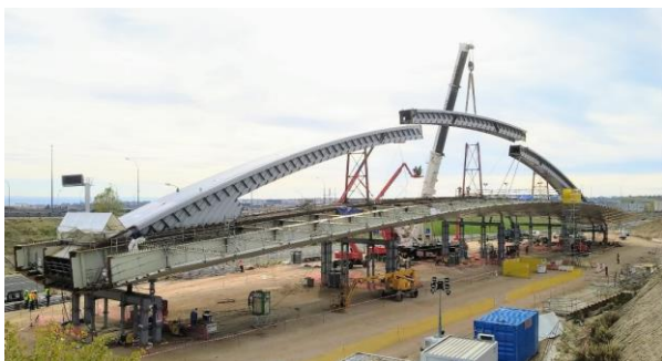
Figura 9. Elevación de la sección central del arco
