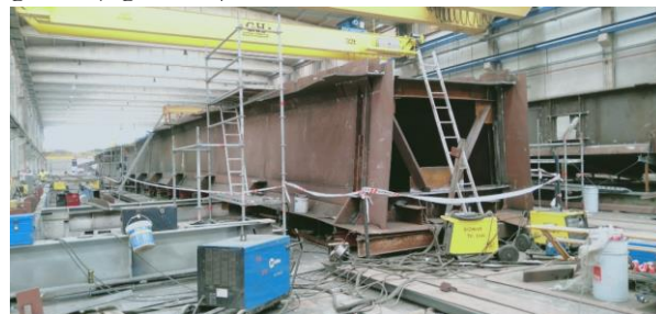
Figura 18. Estructura de acero fabricada en taller
