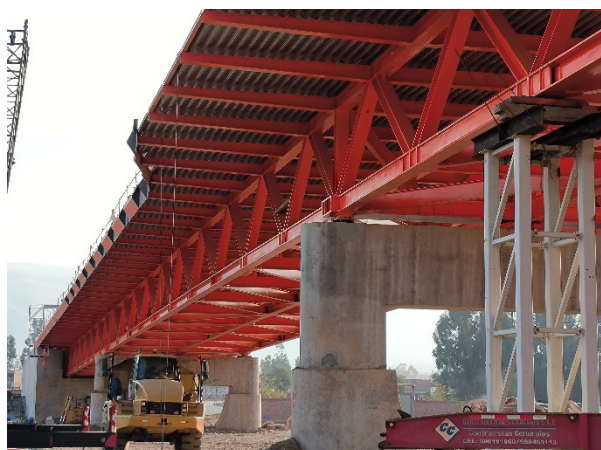
Figura 2. Vista de la celosía durante el montaje
