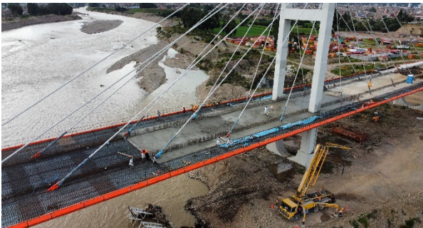
Figura 14. Hormigonado de la losa superior
