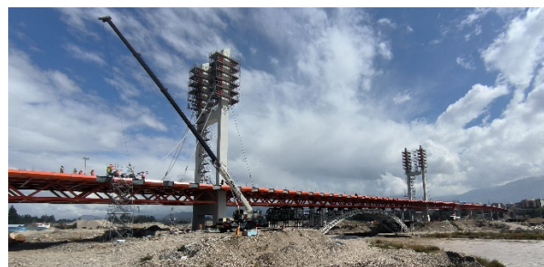
Figura 11. Situación del tablero para la instalación de tirantes
