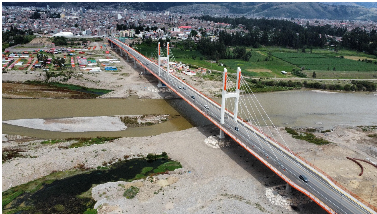
Figura 1. Vista general del puente Max Hongler
