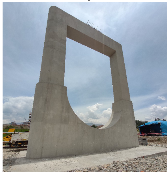
Figura 7. Vista general de pila tipo
