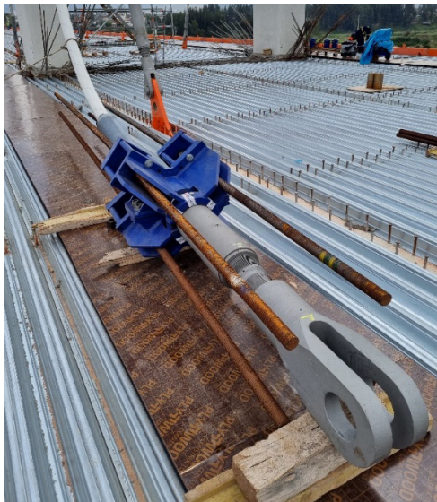
Figura 3. Tirante precortado listo para su tesado
