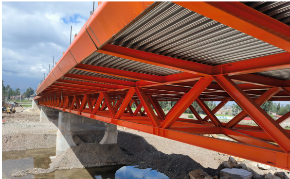
Figura 18. Detalle de tablero con deflectores laterales
