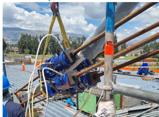
Figura 12. Equipo de tesado de tirantes
