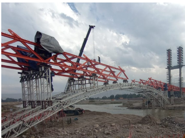
Figura 10. Montaje de celosía sobre “falso puente”
