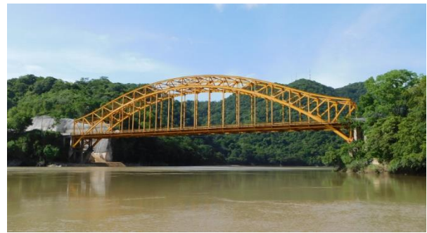
Figura 3. Vista general del puente arco existente.
