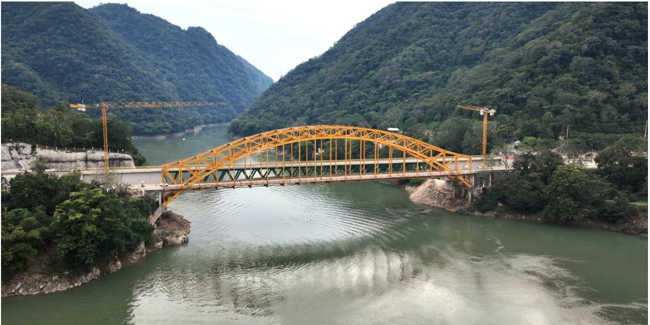
Figura 22. Nuevo puente de boca del cerro fundido en el paisaje que lo rodea.
