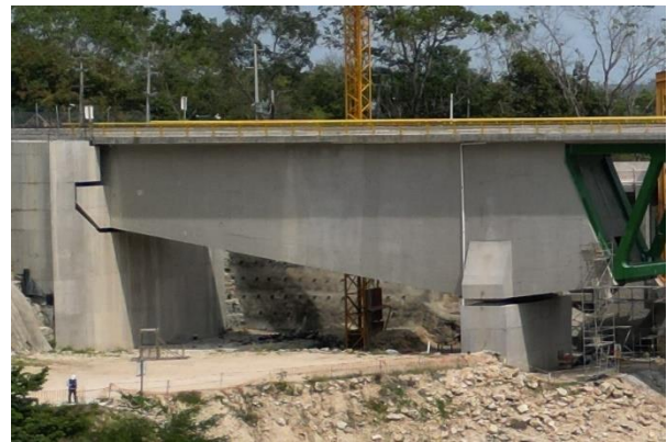
Figura 14. Vano de compensación de hormigón.
