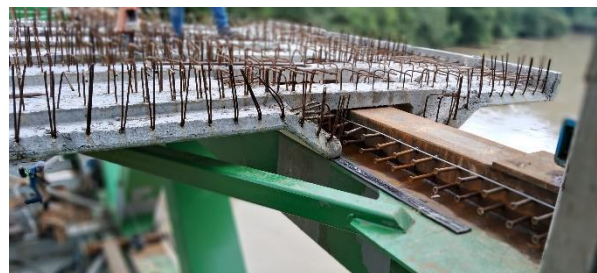
Figura 12. Geometría de las prelasas superiores adaptada al cajoncito superior.
