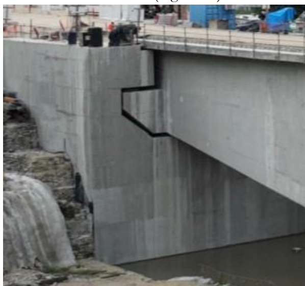
Figura 20. Tope anti levantamiento en estribos.
