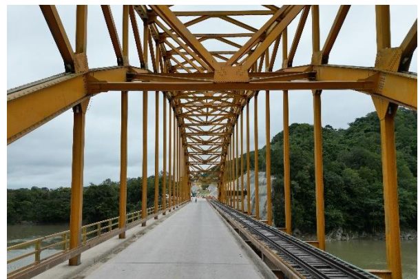
Figura 4. Vista interior del puente arco existente.
