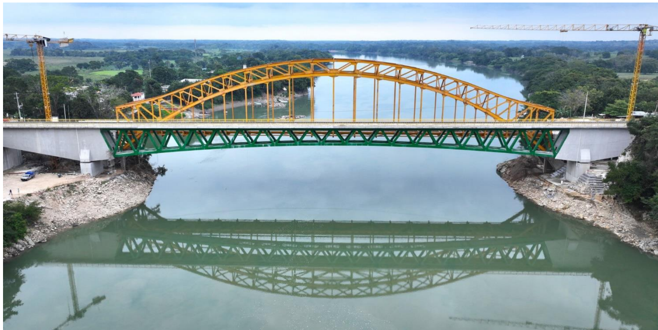
Figura 5. Nuevo puente de Boca del Cerro.
