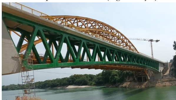
Figura 7. Vista lateral de la celosía.
