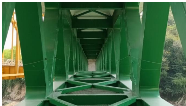
Figura 8. Vista interior de la celosía.
