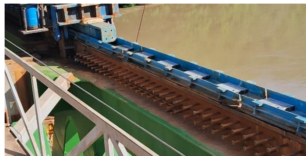
Figura 11. Deslizamiento del carro de izado móvil sobre el cajoncito superior del cordón superior.
