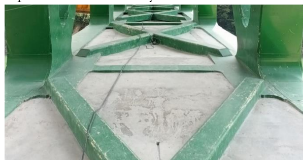
Figura 9. Hormigón de fondo en zona de negativos.
