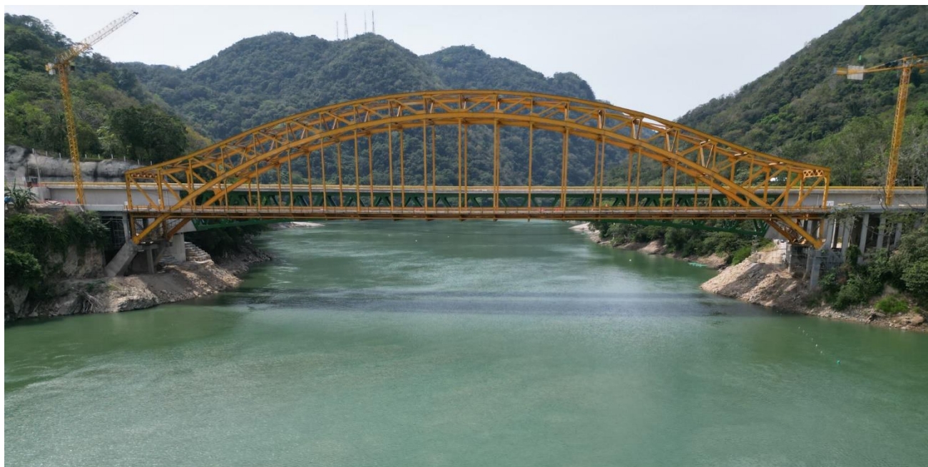
Figura 6. Vista del puente arco existente y el nuevo puente detrás de él.
