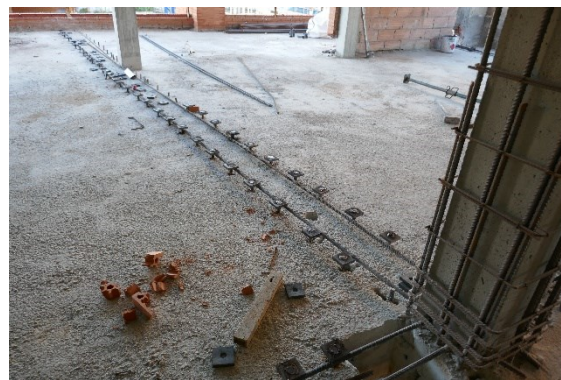
Figura 13. Fase 6 del procedimiento de refuerzo frente a cortante.
