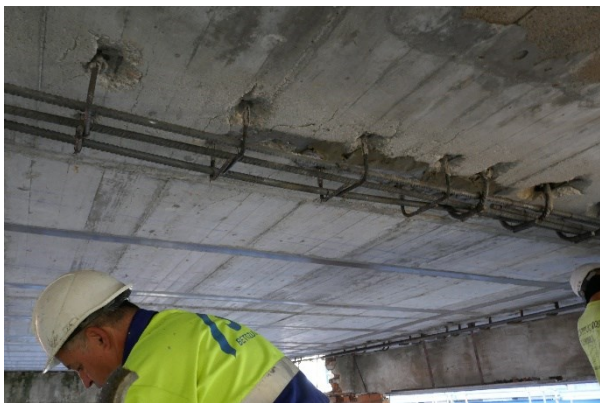
Figura 15. Fase 9 del procedimiento de refuerzo frente a cortante.
