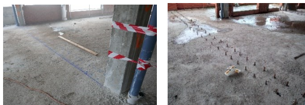
Figura 11. Fases 1 y 3 del procedimiento de refuerzo frente a cortante.
