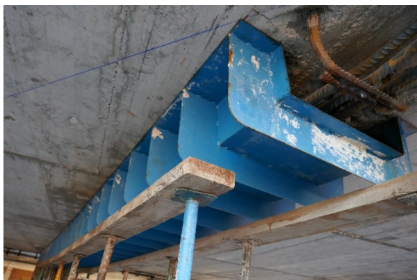
Figura 17. Fase 11 del procedimiento de refuerzo frente a cortante.
