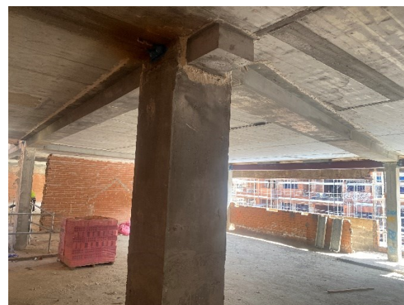
Figura 18. Estado final del refuerzo frente a cortante.
