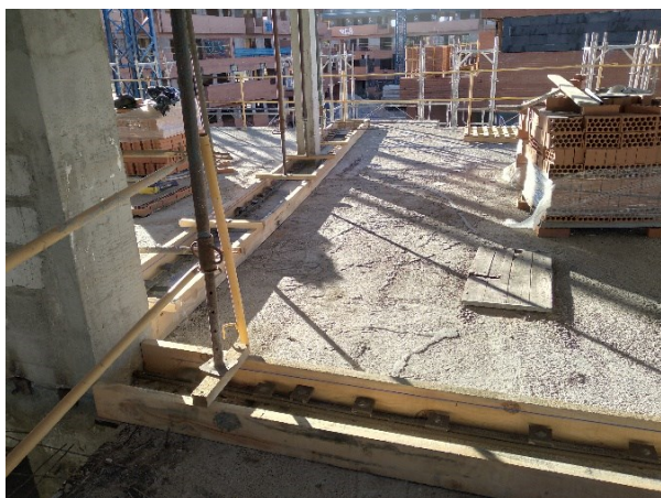
Figura 16. Fase 10 del procedimiento de refuerzo frente a cortante.
