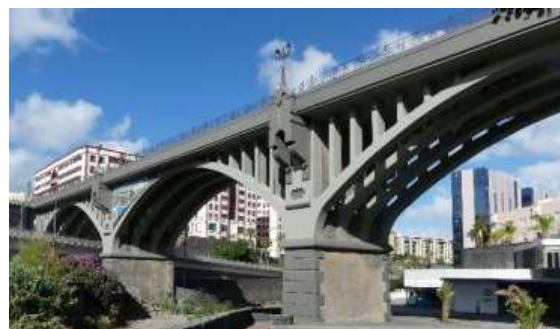
Figura 1. Puente Galcerán. Vista general
