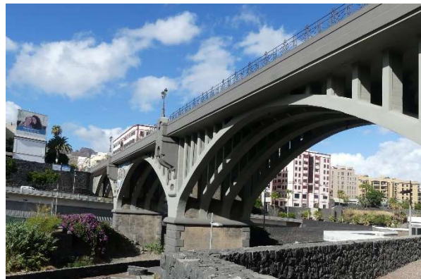
Figura 14. Puente Galcerán. Estado actual, tras la finalización de la obra de rehabilitación
