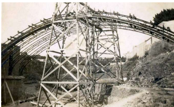
Figura 4. Foto histórica de la autocimbra del puente Galcerán, en fase de construcción
