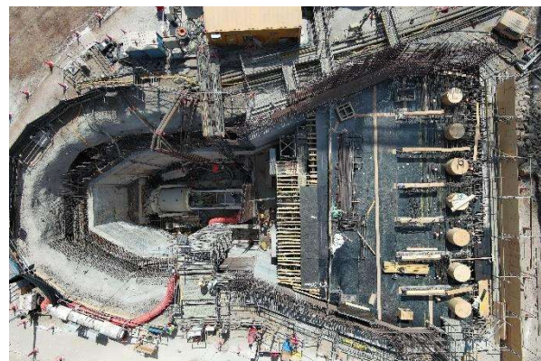
Figura 2. Vista aérea del edificio de toma durante su construcción
