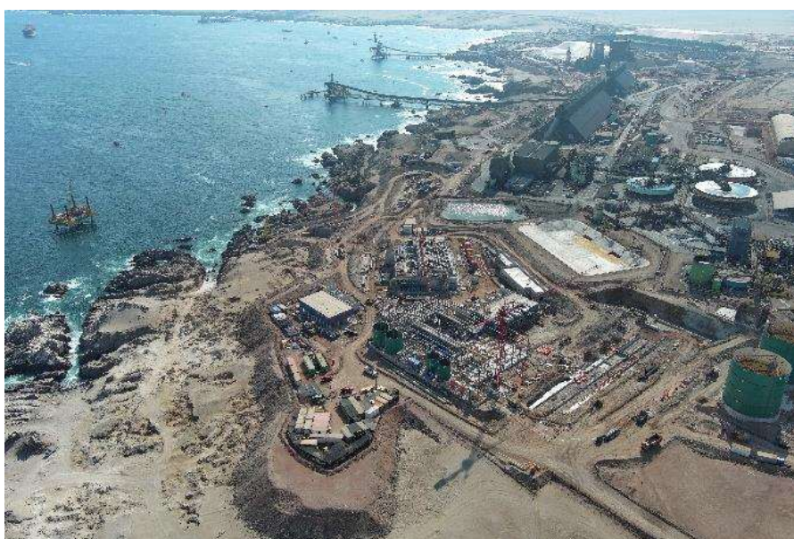
Figura 6. Vista aérea de la obra
