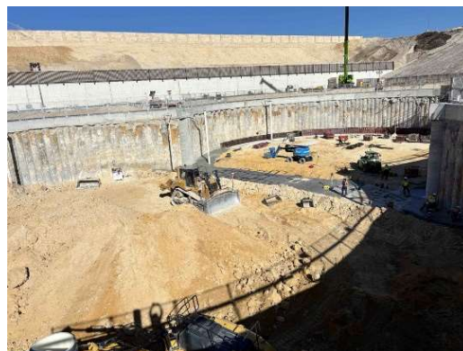
Figura 5. Excavación hasta el primer nivel
