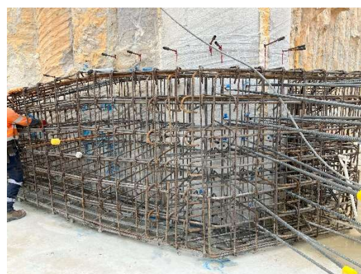
Figura 6. Ejecución de la pantalla de pilotes
