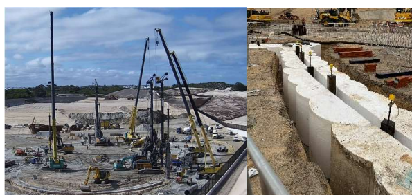
Figura 3. Ejecución murete guía o negativo y de la pantalla de pilotes
