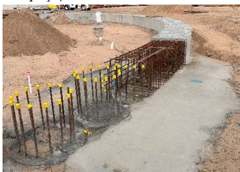
Figura 4. Ejecución de la capping beam
