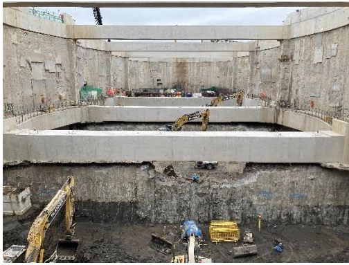
Figura 15. Momento durante la excavación en el que se puede observar cómo en cada burbuja las retroexcavadoras están a un nivel distinto.
