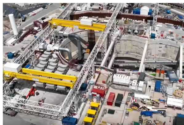
Figura 19. Imagen general con la estructura en funcionamiento dado servicio para la ejecución de los túneles. Imagen tomada de: HS2 video oficial .
