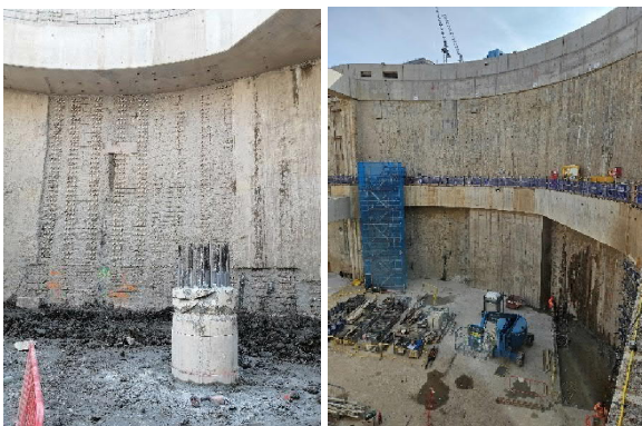
Figura 13. Zona del headwall tras descubrir los acopladores mecánicos previstos y tras la ejecución.
