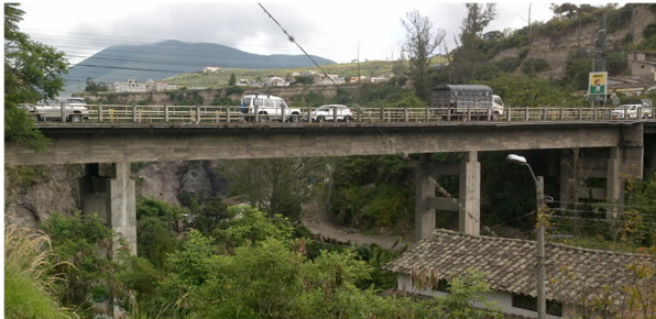
Figura 1. Puente existente de los Molinos sobre el río Tahuando. Fuente: TYPESA.
