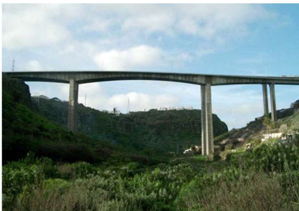
Figura 2. Fracción del viaducto, destinada al cruce sobre el Barranco.
