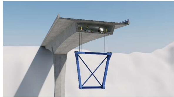
Figura 11. Izado del puntal
