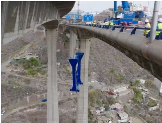
Figura 17. Descenso del puntal
