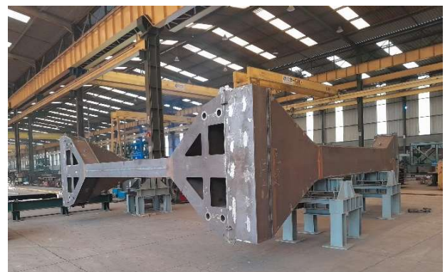
Figura 16. Montaje en blanco del puntal, en taller
