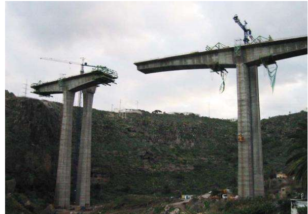
Figura 3. Tramo principal, en fase de ejecución
