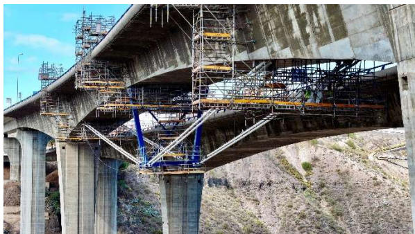
Figura 22. Montaje de tendones extradados
