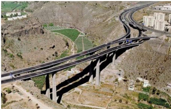
Figura 1. Viaducto del Guiniguada. Vista general
