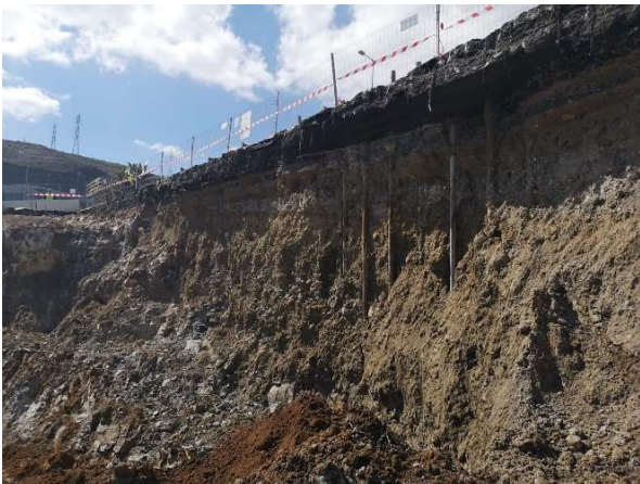
Figura 2. Pantalla de micropilotes, que queda a la vista
