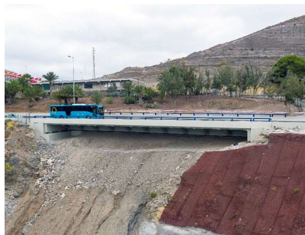
Figura 24. Aspecto de la obra, terminada
