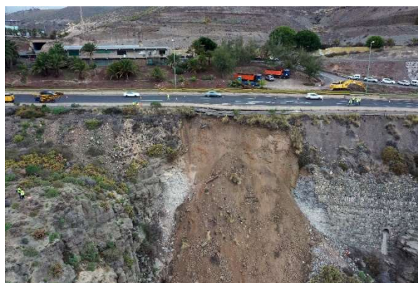
Figura 1. Aspecto del derrumbamiento.
