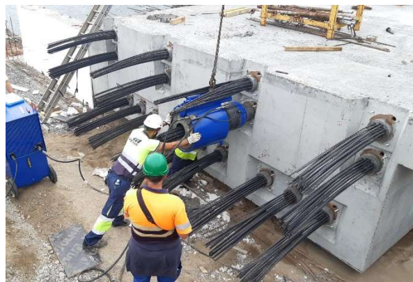
Figura 8. Tesado de la armadura activa longitudinal del núcleo
