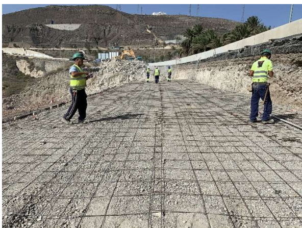
Figura 6. Preparación de la superficie del terreno, utilizado como cimbra de soporte del núcleo en fase de hormigonado
