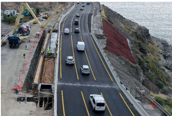
Figura 17. Hormigonado del voladizo del lado interior
