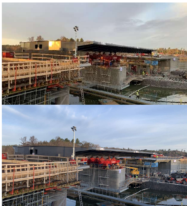
Figura 14. Descenso sobre estructura de pila 5.
