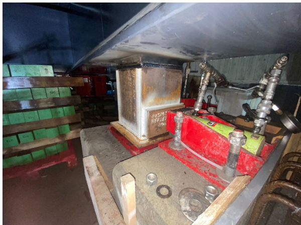
Figura 16. Vista de la mesa de ajuste donde se puede observar el enano de apoyo provisional y uno de los gatos horizontales.
