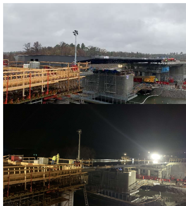
Figura 15. Descenso sobre castilletes de pilas 4 y 6.
