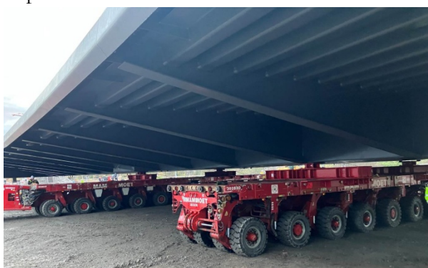
Figura 7. Plataformas SPMT sosteniendo el tablero en diafragmas 8 y 12.
