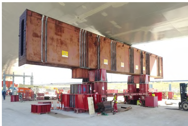
Figura 3. Estructura auxiliar sobre gatos de trepa
