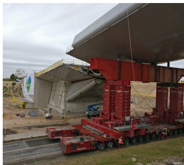
Figura 16. Puente en posición para iniciar el descenso
