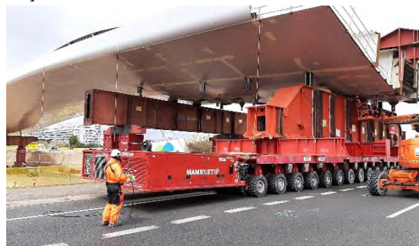
Figura 18. Prismas para control geométrico y marcas en el vial
