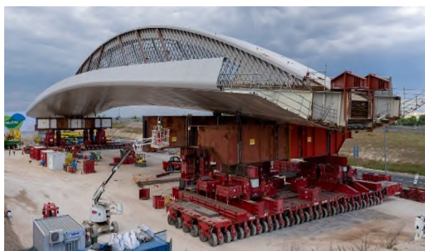
Figura 4. Pareja de sets de spmt con equipos de elevación Megajack recogidos
