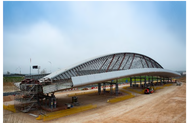
Figura 2. Vista general del tramo central del puente tras la finalización del ensamblaje de la estructura metálica
