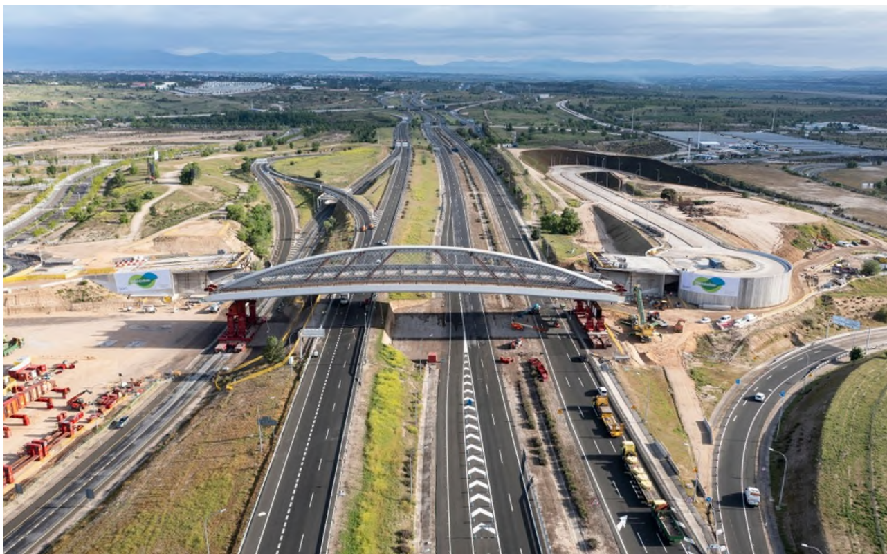
Figura 9. Fase final de traslación, paralela a la M-12, hasta ubicación definitiva
