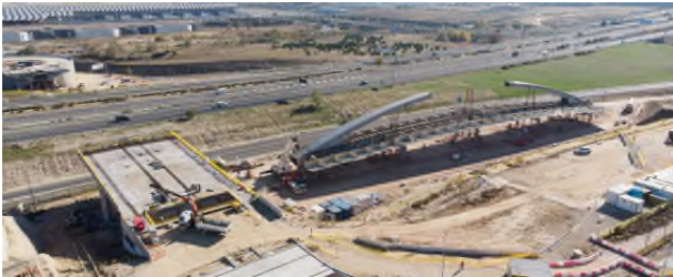
Figura 1. Montaje en un lateral de la obra del tramo central a partir de las dovelas prefabricadas en taller
