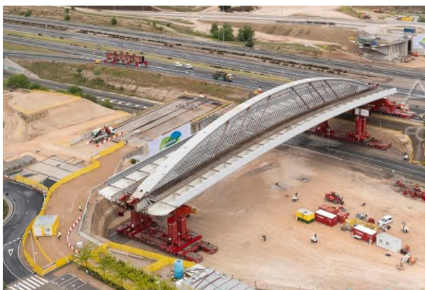
Figura 7. Fin de la fase de rotación
