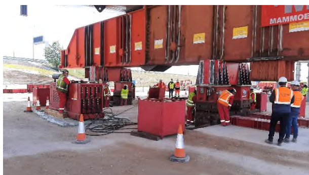
Figura 11. Gatos de trepa en funcionamiento
