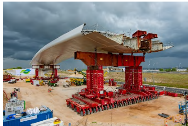
Figura 5. Estado final de la fase de elevación
