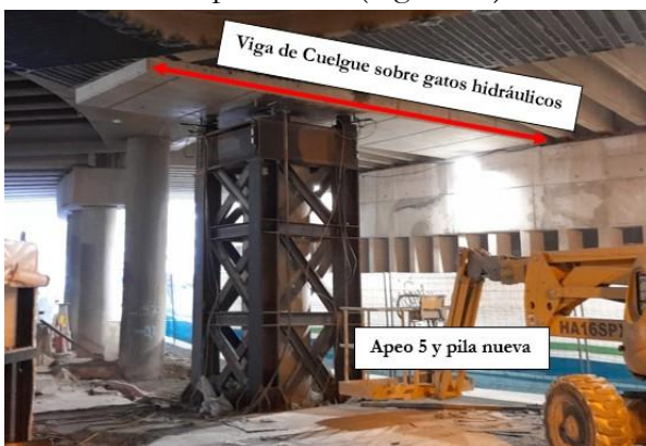
Figura 12. Apeo 5 alrededor de la nueva pila.
