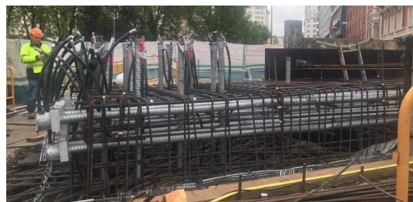
Figura 10. Detalle de armado de viga de cuelgue.
