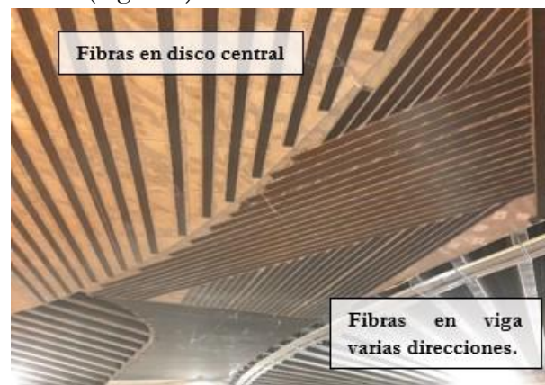
Figura 7. Fibras de carbono adheridas en cara inferior.
