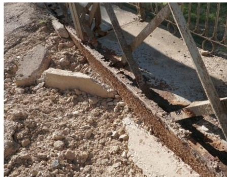
Figura 8. Relleno del tablero.
