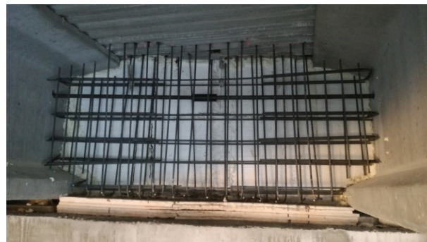
Figura 7. Viga riostra de hormigón armado.
