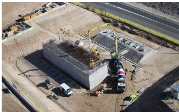
Figura 1. Vista general de las cimentaciones del puente
