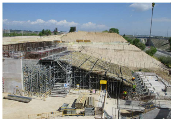
Figura 2. Vista general de la cimbra cuajada colocada para la ejecución del cartabón de hormigón
