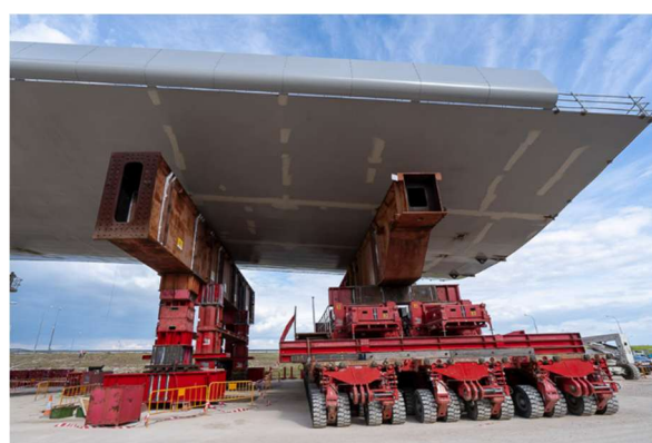
Figura 12. Equipos de elevación y plataformas modulares autopropulsadas
