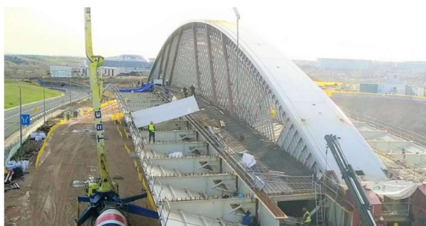
Figura 11. Ensamblaje del diagrid con sus refuerzos
