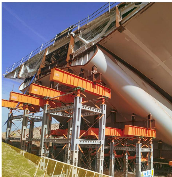
Figura 4. Vista general de las torres de apeo de los arranques metálicos
