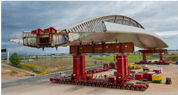
Figura 13. Maniobra de traslado y colocación del tramo central de la estructura
