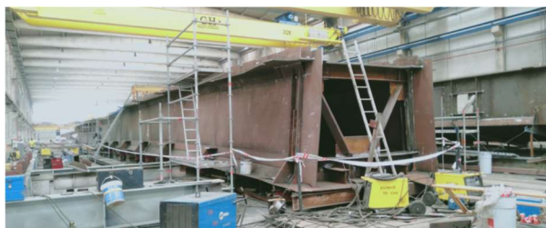
Figura 7. Trabajos de ensamblaje de la estructura metálica en taller
