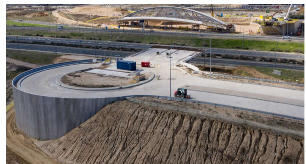
Figura 6. Vista de la rotonda de acceso al estribo 2 del puente
