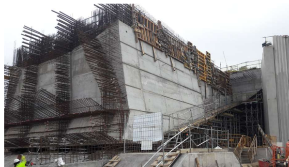
Figura 3. Vista general del cartabón hormigonado sobre la cimbra
