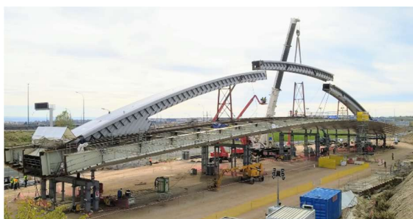
Figura 10. Ensamblaje del arco en campa
