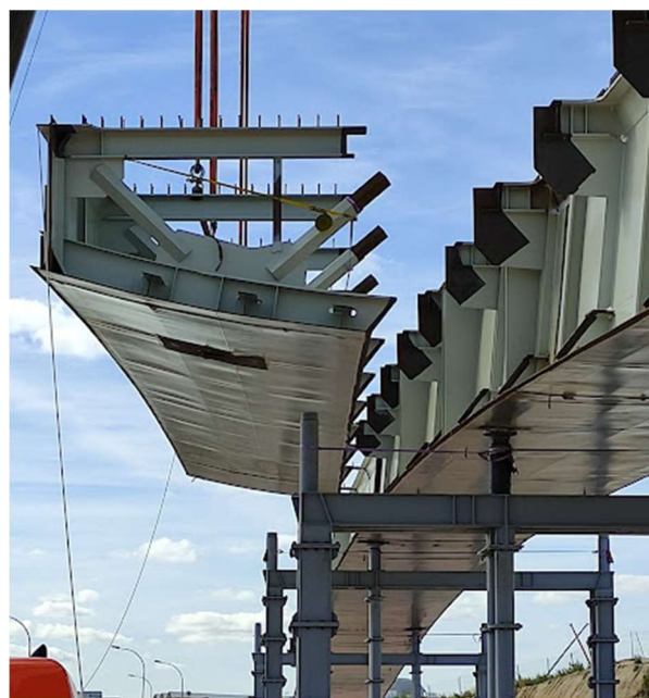
Figura 9. Ensamblaje del tablero en campa
