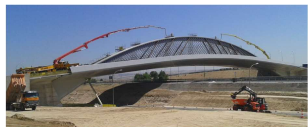
Figura 14. Fases del hormigonado de relleno del arco
