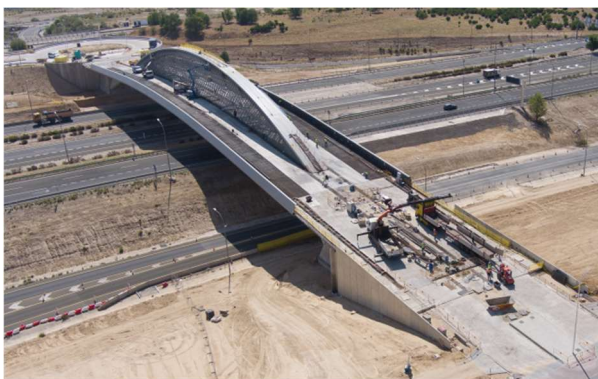
Figura 16. Hormigonado de la losa superior del tablero
