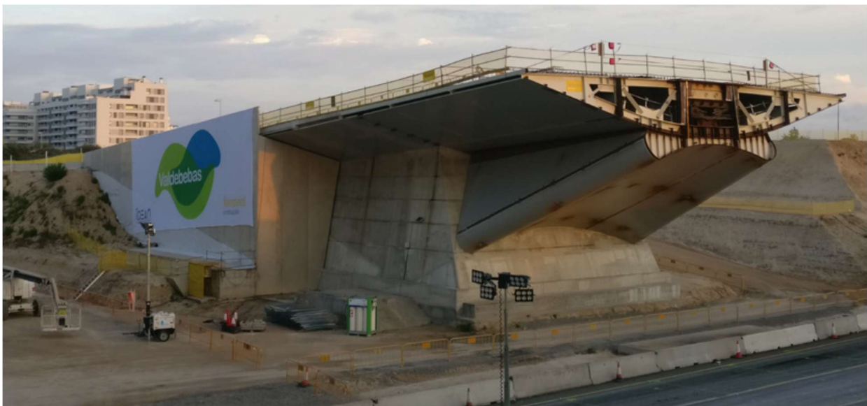
Figura 5. Vistas generales de la instalación de los muros laterales y el estado final del estribo 1
