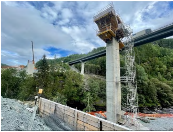
Figura 3. Fotografía de la construcción de las pilas con la distribución de trepas.
