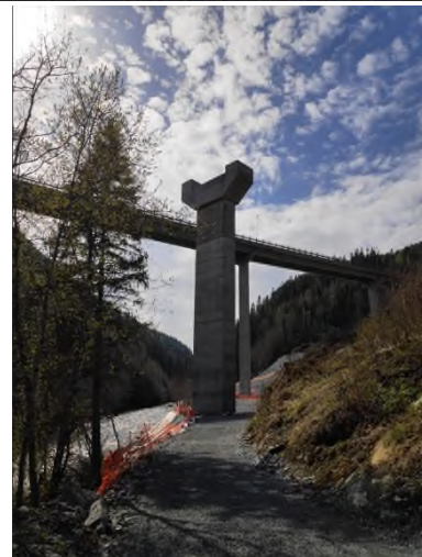
Figura 5. Imágenes de la pila más alta del viaducto E62 y del viaducto existente adyacente.
