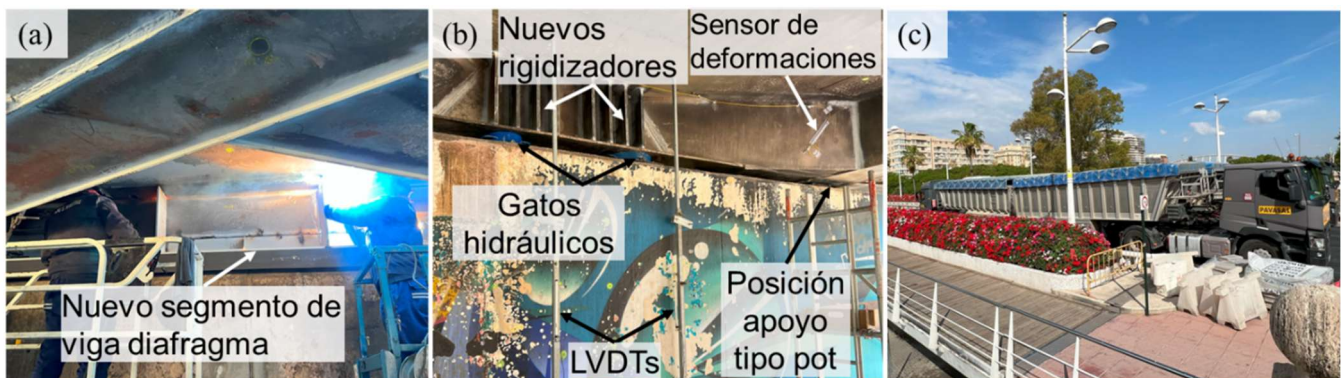
Figura 9. Trabajos de reparación: (a) Sustitución de la sección dañada de la viga diafragma. (b) Elevación del tablero para permitir el reemplazo de los apoyos tipo pot. (c) Prueba de carga.
