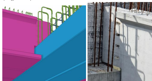
Figura 8. Apoyo de vigas VSA. Modelo BIM y estructura en montaje.
