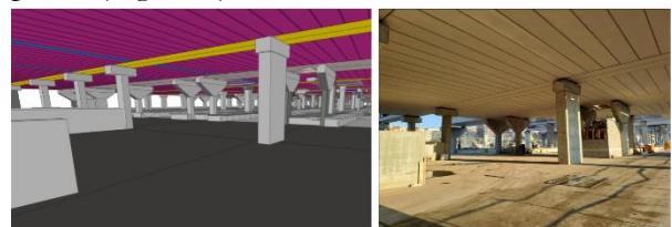
Figura 4. Vista inferior aspecto de “techo plano”, modelo BIM y estructura terminada.
