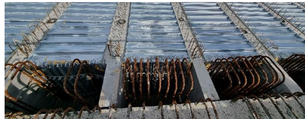
Figura 15. Chapa de encofrado perdido sobre VSA y JP con sector 1 ejecutado y sector 2 ya encofrado.
