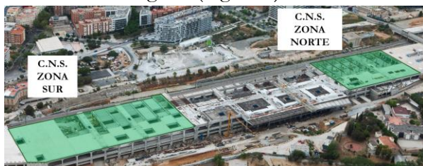
Figura 2. Cubierta No Singular (sombreado en verde). Estado de las obras en agosto de 2024.
