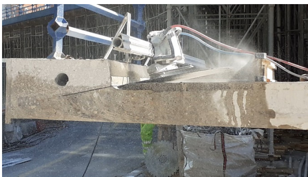
Figura 11. Corte con disco para extracción de dado de hormigón rodeando el tubo de fibrocemento.
