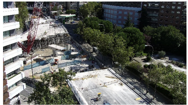
Figura 12. Avance de las obras en la zona de cruce con c/ Príncipe de Vergara.
