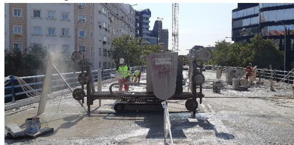
Figura 9. Corte de hormigón con hilo de diamante.
