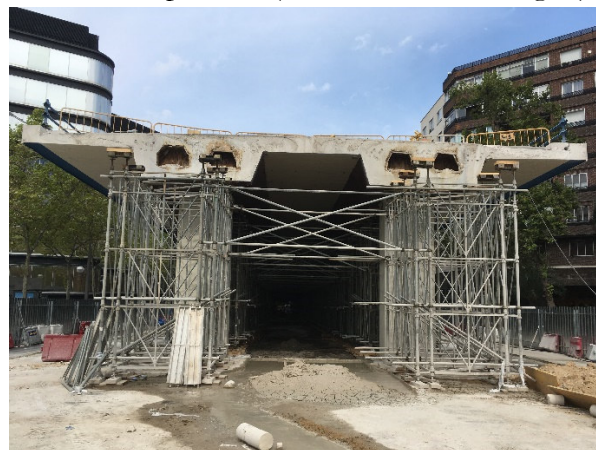
Figura 6. Cimbra bajo tablero de tronco principal.
