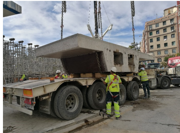
Figura 13. Posicionamiento de dovela sobre góndola.
