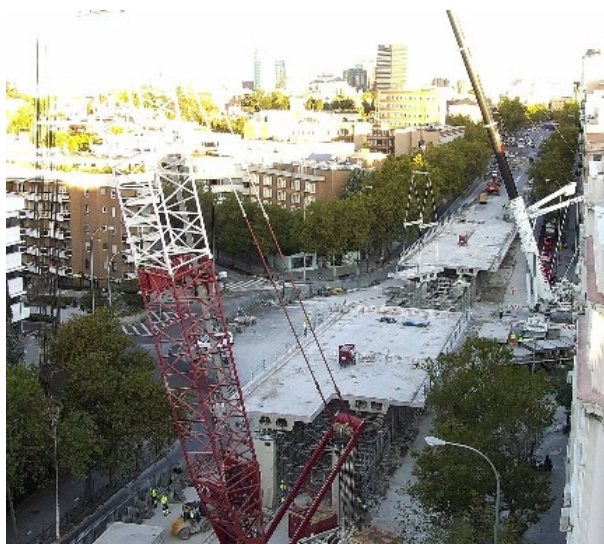
Figura 14. Vista general de la obra.
