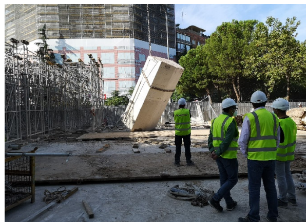
Figura 7. Izado de dovela de pila cortada a cota de pavimento con hilo de diamante.
