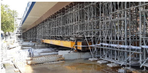
Figura 8. Cimbra del vano 9 apoyada en perfiles que puentean el túnel de María de Molina.
