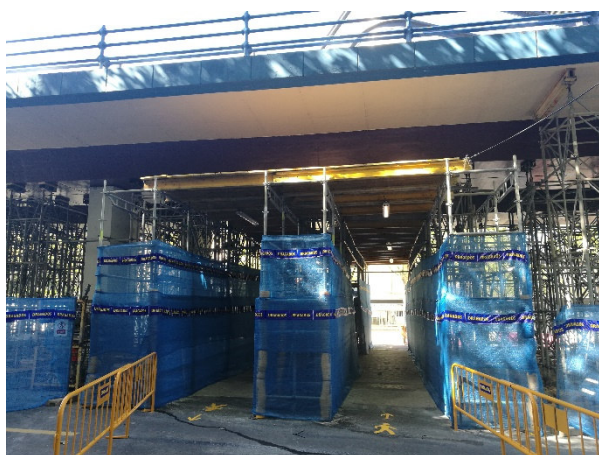
Figura 5. Cimbra porticada en paso de peatones de vano 6.
