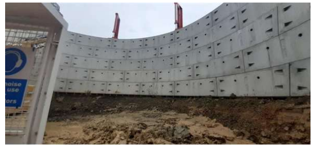
Figuras 9 y 10. Westgate. Ejecución de las dovelas prefabricadas. “Caisson sinking”
