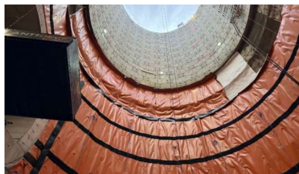
Figura 7. Victoria Road Ancillary Shaft durante su construcción
