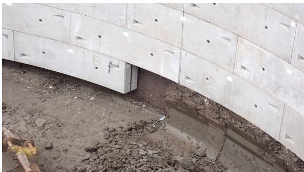
Figura 8. Canterbury Works. Ejecución de las dovelas prefabricadas. “Underpinning”
