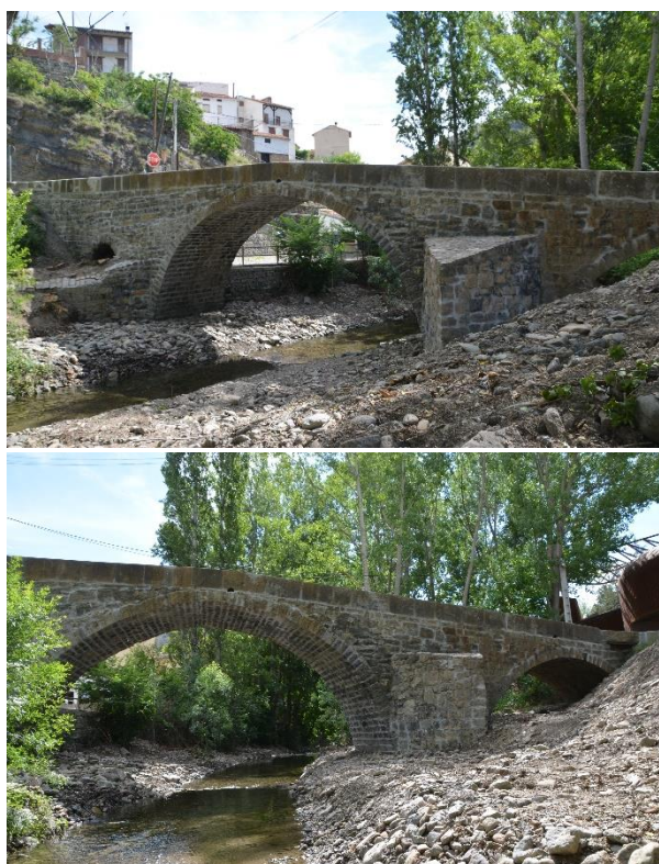
Figura 26. Sendas vistas del alzado derecho del puente al concluir los trabajos (junio de 2024). Arriba, bóvedas 1 y 2; abajo, a la derecha, bóveda 3.
