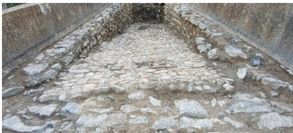
Figura 17. Pavimento original del puente
