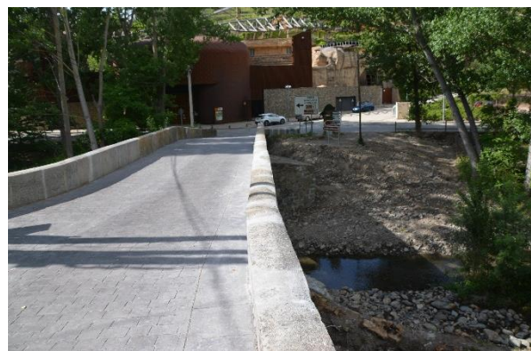
Figura 25. Configuración final de la plataforma acabada.
