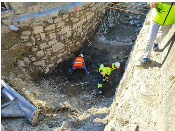
Figura 18. Vista de las labores de vaciado del seno dorsal a bóveda 1 y pila 2.
