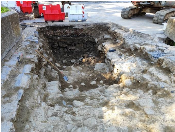
Figura 22. Vista del vaciado tras bóveda 3, hacia E2.
