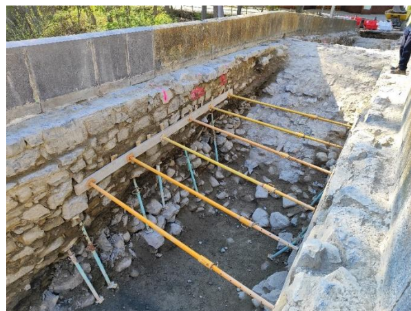
Figura 19. Vista del apeo interior de los tímpanos.
