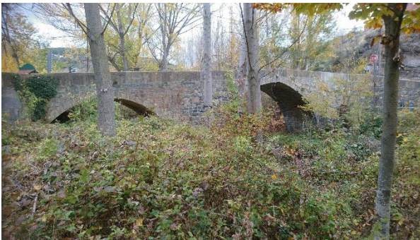
Figura 1. Vista general desde aguas abajo del puente.
