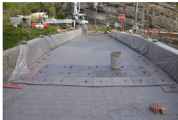
Figura 24. Hormigón impreso en primer término, moldes ya dispuestos y hormigón aún sin imprimir.
