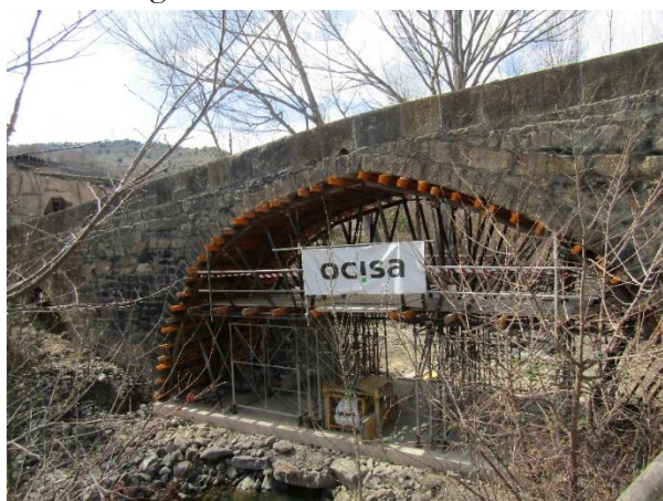
Figura 14. Disposición de bóveda bajo bóveda 2.
