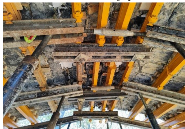
Figura 15. Cimbra perfectamente acuada.
